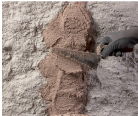
Préparation des bandes de nivellement
