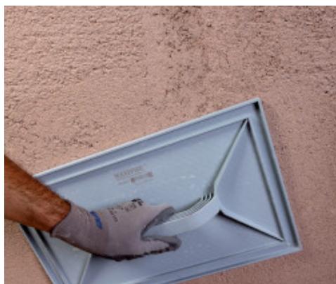
Nivellement de la surface de Mape-Antique CC
