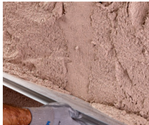
Aplanir la surface de Mape-Antique CC avec une règle droite
