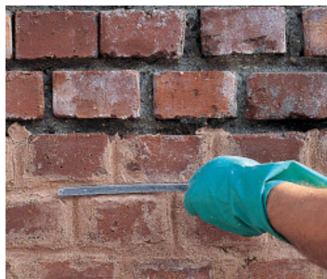
Finition des joints rénovés avec MAPE-ANTIQUE CC
