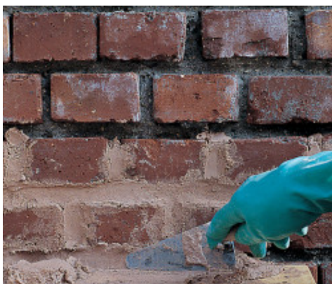
Rénovation des briques avec MAPE-ANTIQUE CC
