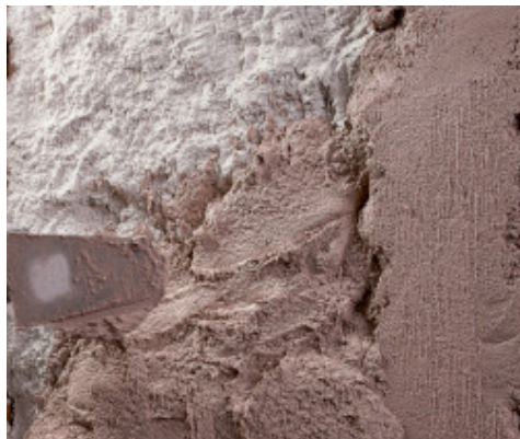
Application du Mape-Antique CC sur Mape-Antique Rinzafo
