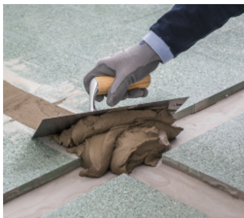
Rebouchage avec Planipatch Xtra
