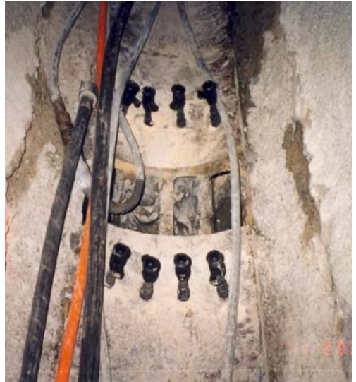
Ausinjizieren Knaufischer Sohlstein mit STABILCEM Zementleim
