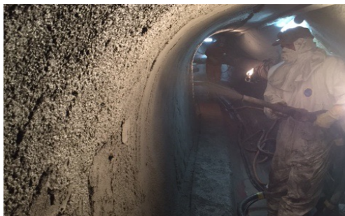
Auftrag des Mörtels im Nassspritzverfahren
