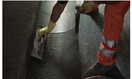
Auftragen der Feinspachtelung in der Sohle
