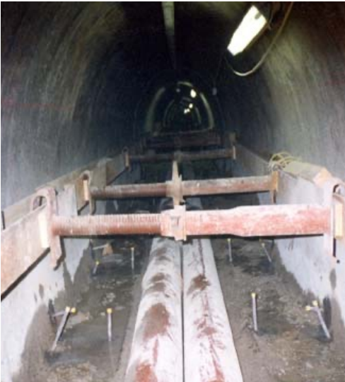
Injektionsarbeiten Sohle STABILCEM
