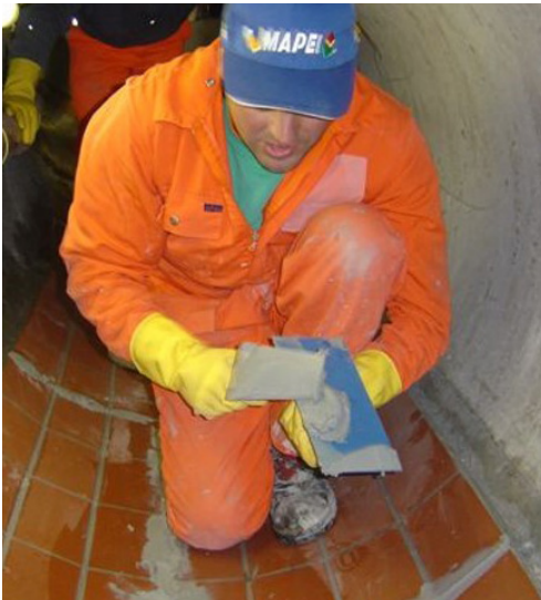
Verfugung mit KERAPOXY mittels Gummibrett
