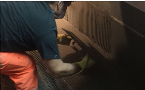
Auftragen der Feinspachtelung in der Sohle
