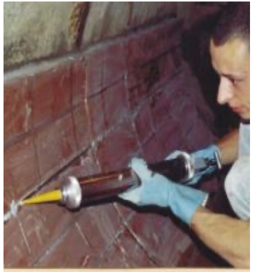
Verfugung mit KERAPOXY mittels Auspresspistole
