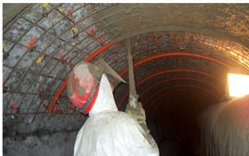
Spritzapplikation überkopf
