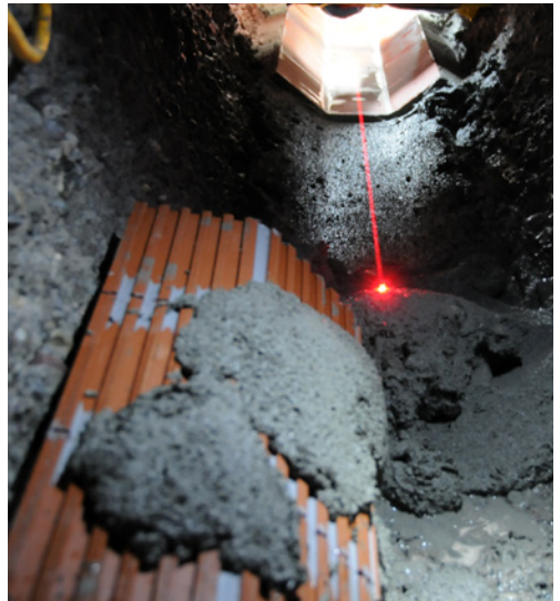
Aufmörteln für Sohlschalen
