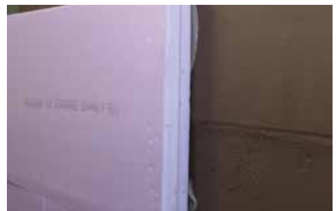
Dämmung kleben
