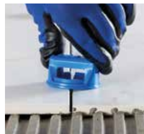
Vor der Feinnivellierung
