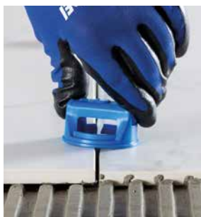
Vor der Feinnivellierung
