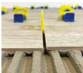
Vor der Feinnivellierung
