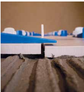
Vor der Feinnivellierung
