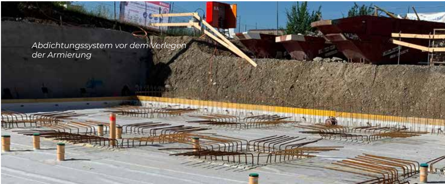
Baustelle mit Abdichtungssystem
