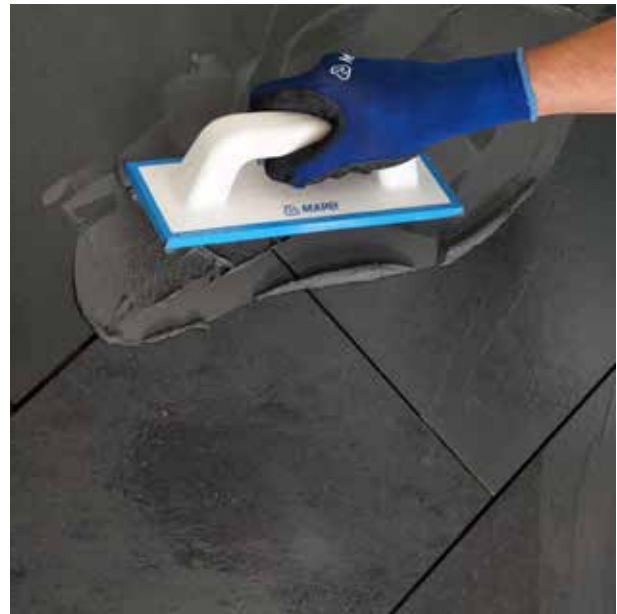
Verfügen des Belags mittels Fugscheibe
