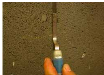
Oberflächenprofilierung mittels Metallglättspatel
