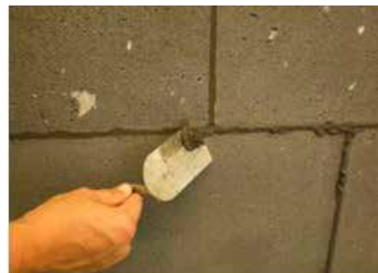
Nach ausreichendem Ansteifen erfolgt das oberflächenbündige „Absteichen“ des überstehenden Fugenmörtels.
