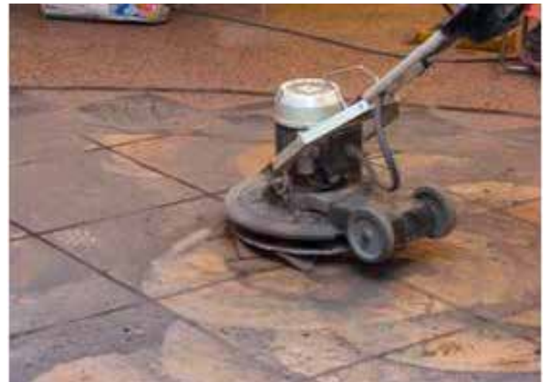
Maschinelles Einarbeiten des Trockenpulvers in den frischen Fugenmörtel
