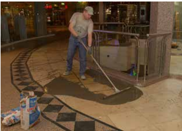
Einschlämmen des Belags mittels Gummiwischer
