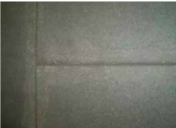
Randverfärbung im Naturstein, hervorgerufen durch die Anwendung eines ungeeigneten Applikationsverfahrens
