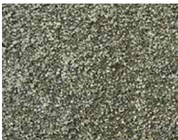
Vorschriftsmäßig mit abgesandetem Epoxidharz geschützte Calciumsulfatestrichfläche
