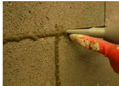
Einspritzen des schnell erhärtenden und schnell trocknenden Fugenmörtels in den Fugenquerschnitt eines openporigen Basaltbelags.
