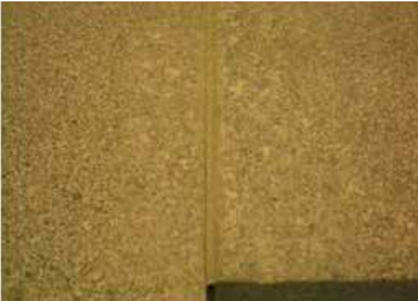
Unvollständiger Füllgrad des Fugenquerschnitts auf Grund zu schmaler Fugenbreite
