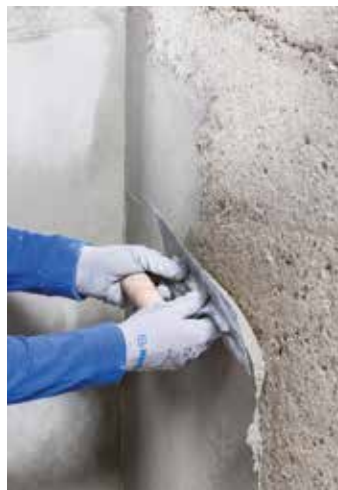
Auftragen von PLANITOP RASA & RIPARA R4 mit der Glättkelle
