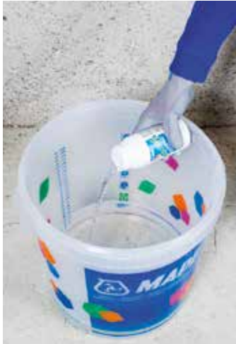
Zufügen von MAPETARD ES ins Anmischwasser des PLANITOP RASA & RIPARA R4
