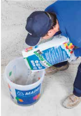
Zufügen von PLANITOP RASA & RIPARA R4 ins Anmischwasser mit bereits zugefügtem MAPETARD ES
