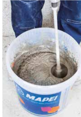
Anmischen von PLANITOP RASA & RIPARA R4
