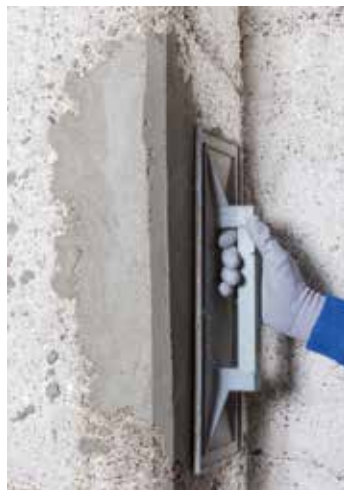
Abtalschieren von PLANITOP RASA & RIPARA R4 für eine glatte Oberfläche
