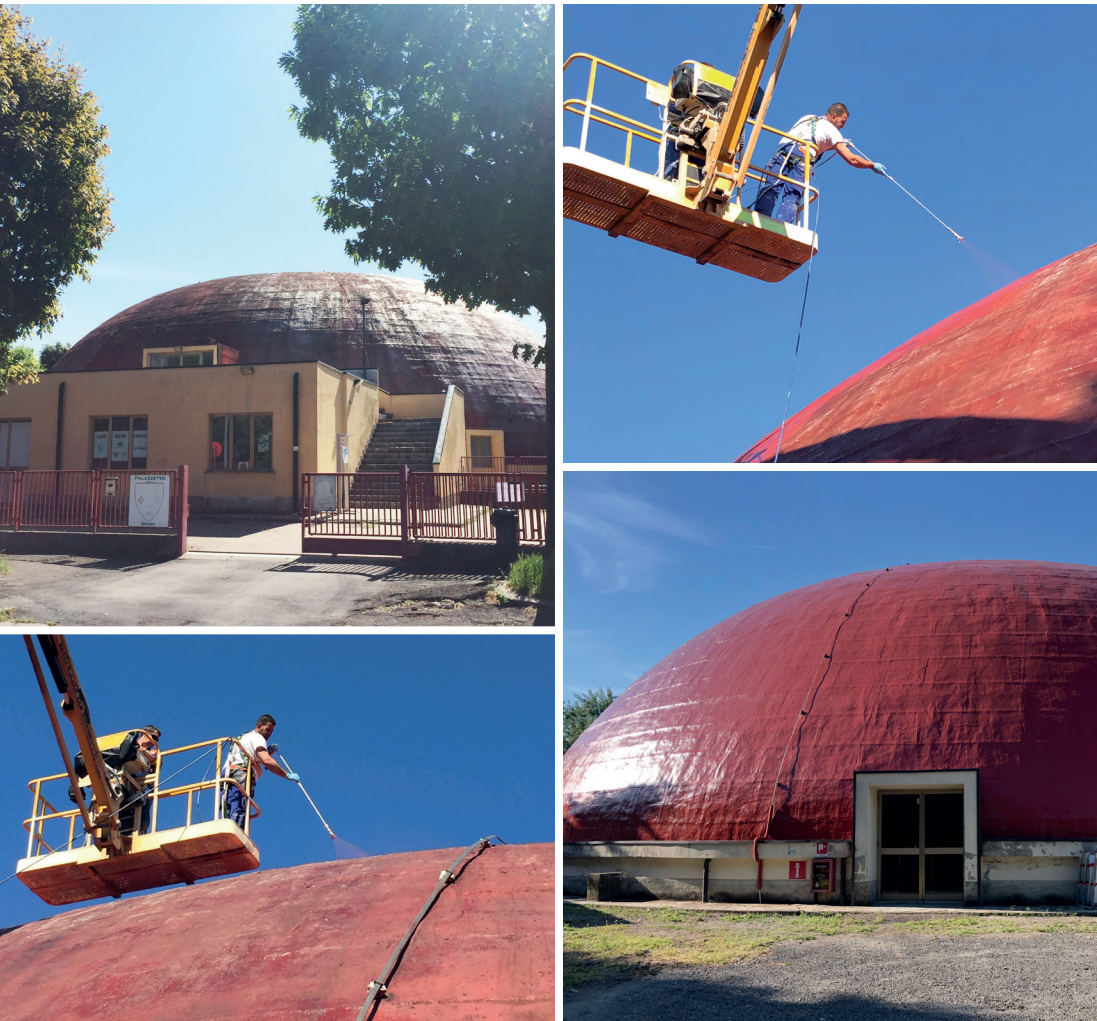
Sanierung einer Abdichtungsbahn mit PURTOP EASY – Novi Ligure, Italien
