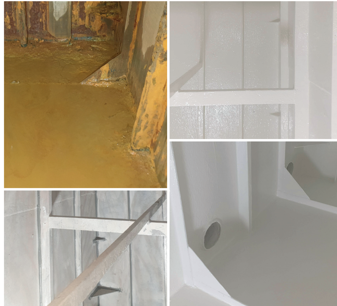
Sanierung eines Wassertanks mit PURTOP EASY DW – Dolo, Italien
