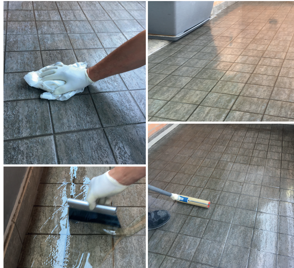
Sanierung einer Balkonabdichtung mit PURTOP EASY T – Mailand, Italien
