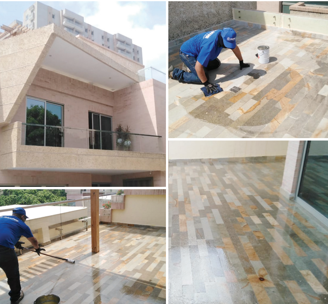
Sanierung einer Balkonabdichtung mit PURTOP EASY T – Kolumbien
