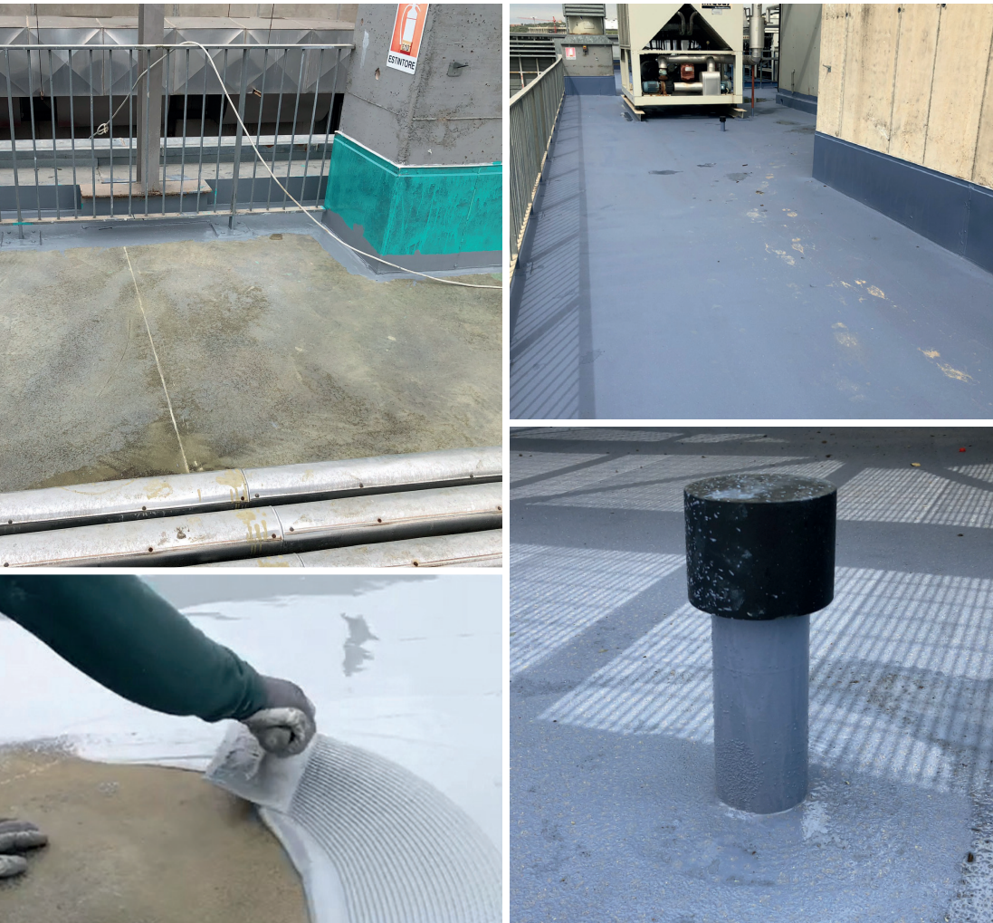
Abdichtung eines Flachdachs mit PURTOP EASY – Catania, Italien
