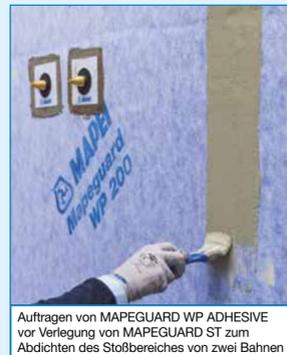
Auftragen von MAPEGUARD WP ADHESIVE vor Verlegung von MAPEGUARD ST zum Abdichten des Stoßbereiches von zwei Bahnen
