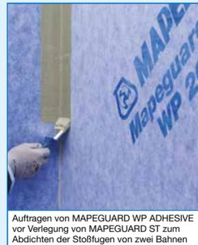
Auftragen von MAPEGUARD WP ADHESIVE vor Verlegung von MAPEGUARD ST zum Abdichten der Stoßfugen von zwei Bahnen
