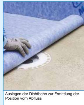
Auslegen der Dichtbahn zur Ermittlung der Position vom Abfluss
