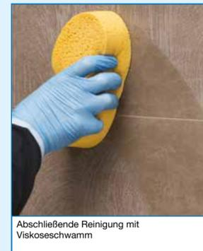
Abschließende Reinigung mit Viskoseschwamm
