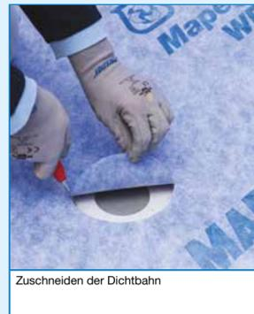
Zuschneiden der Dichtbahn
