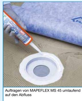
Auftragen von MAPEFLEX MS 45 umlaufend auf den Abfluss
