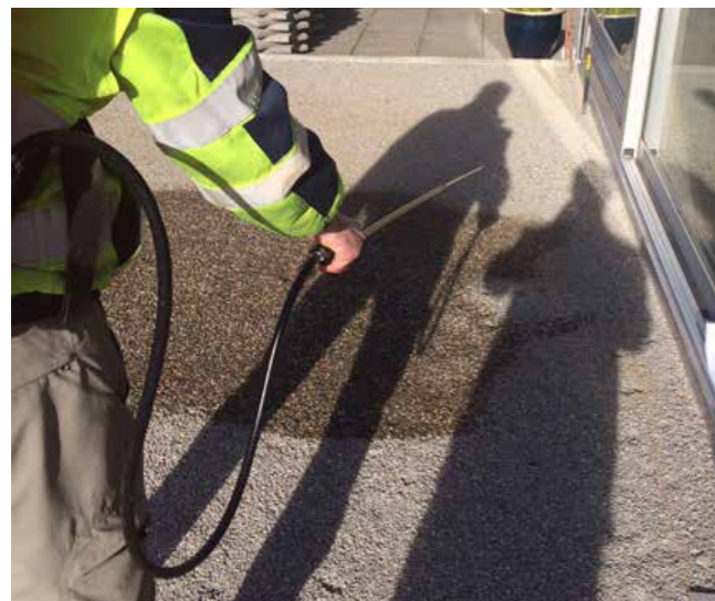
Aufsprühen von MAPESTOP
