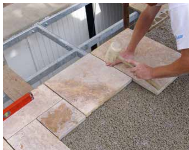
Verlegung auf erhärtetem Drainageestrich im Buttering-Verfahren
