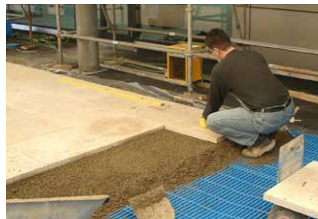
Verlegung „frisch in frisch“ mit der Haftbrücke Elastorapid in den Drainagemörtel
