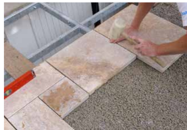
Verlegung auf erhärtetem Drainageestrich im Buttering-Verfahren
