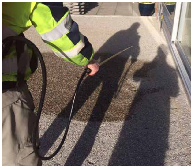
Aufsprühen von MAPESTOP
