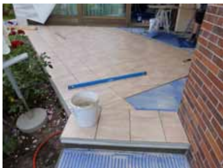
Bild links: Applikation des 2-komponentigen Schnellklebesystems ELASTORAPID in der „Buttering-Methode“ vor dem Ansetzen der großformatigen Platten auf die Tragstege.
