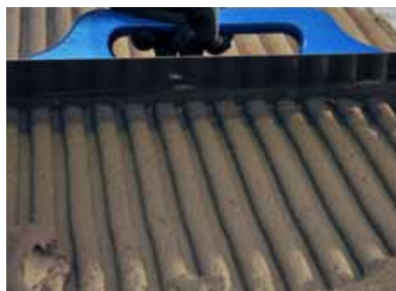
Aufziehen von Tragstegen mit PLANITOP FAST 330, einem schnell reagierenden, feinkörnigen Mörtel mit geringem Ausblühpotential.
