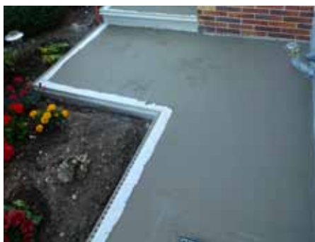
Mit Verbundabdichtung MAPELASTIC und Randprofilen vorbereitete Terrassenfläche.
