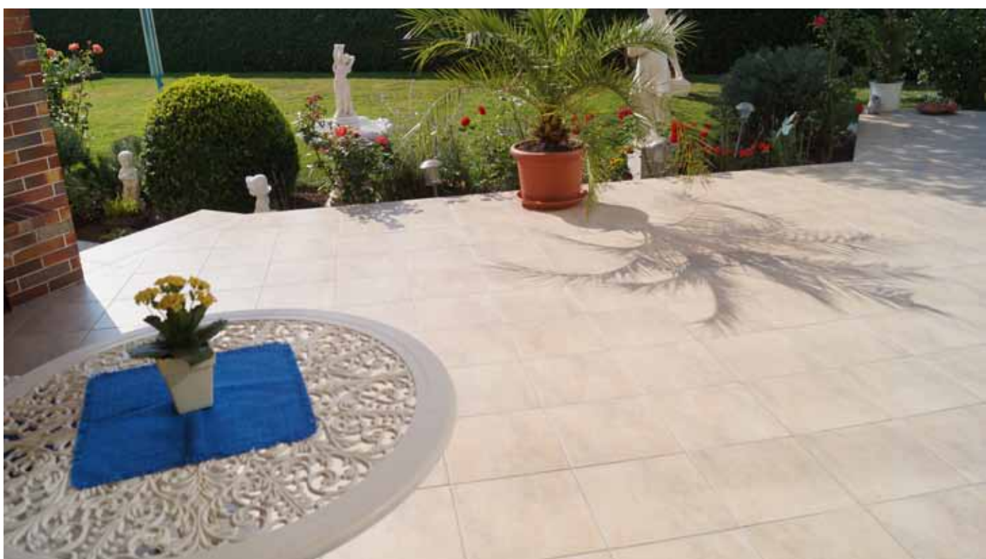
Bild rechts oben: Verfugen eines mittels BDC-System verlegten Keramikbelages mit dem Hochleistungsfugenmörtel ULTRACOLOR PLUS.
