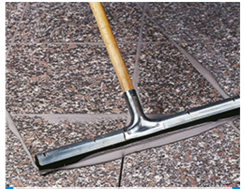
Verfugung eines polierten Granitbodens mit einem Gummiwischer
