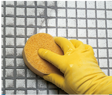
Reinigen des Glasmosaiks mit einem Schwamm
