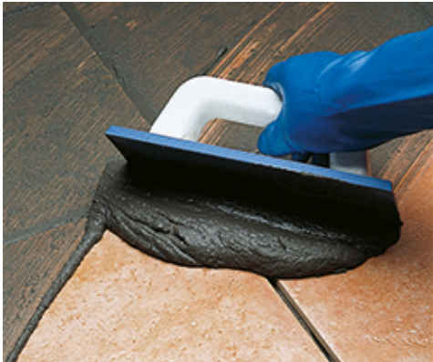
Verfugung einer Keramik mit einer Gummifugscheibe
