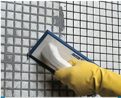
Verfugung von Glasmosaik (Badezimmer) mit einer Gummifugscheibe
