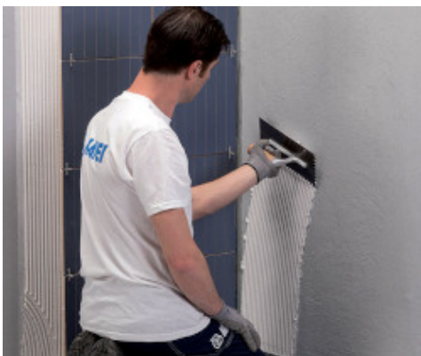
Ansetzen des Belags mit Ultramastic III
