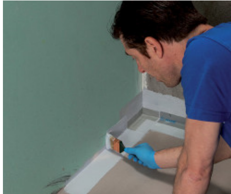
Einbau Mapeband PE 120 mit Mapegum WPS
