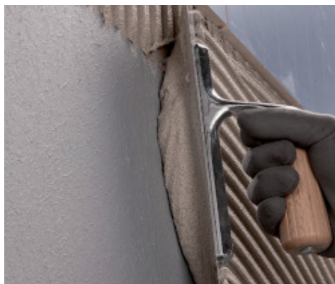
Ansetzen des Belags mit Keraflex S1
