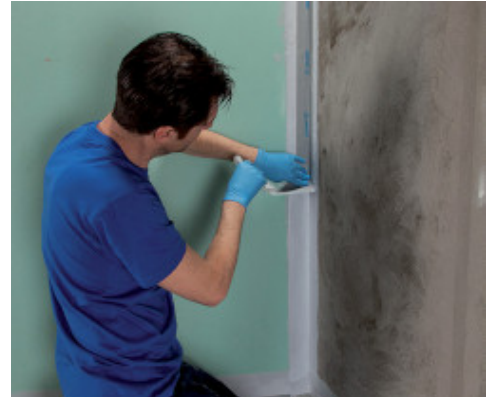
Einbau Mapeband PE 120 mit Mapegum WPS
