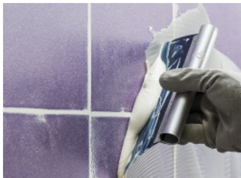
Auftragen von Ultrabond Eco MS 4 LVT Wall&Floor mit einem Zahnpachtel auf einem nichtsaugenden Untergrund
