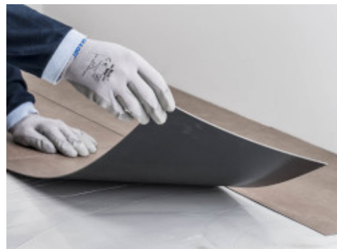
Verlegung von Designbelag mit Ultrabond Eco MS 4 LVT Wall&Floor am Boden im Feuchtraum
