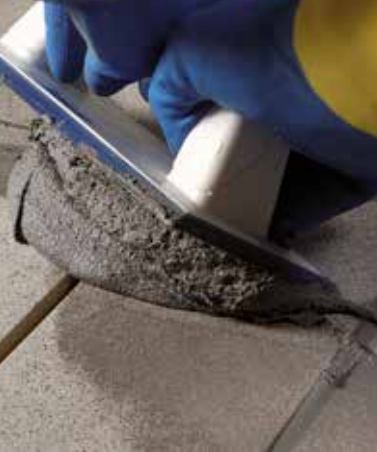
Auftragen von Kerapoxy CQ mit einem MAPEI-Fugenbrett
