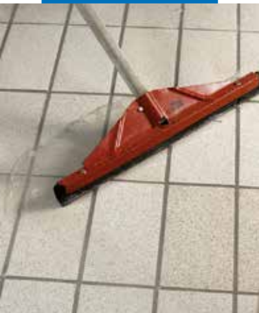
Überschüssiges Waschwasser wird mit einem Gummischieber abgezogen
