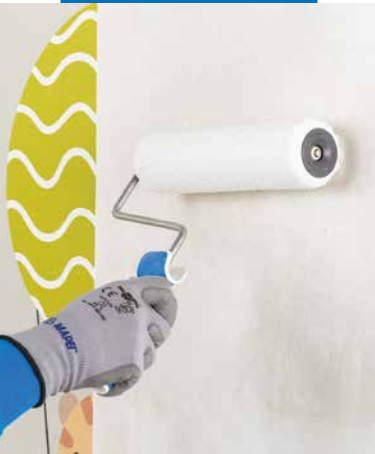
Auftragen von Ultrabond Eco Decor Dry
