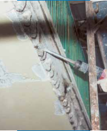
Instandsetzung einer Balkonbrüstung: Untergrundvorbereitung
