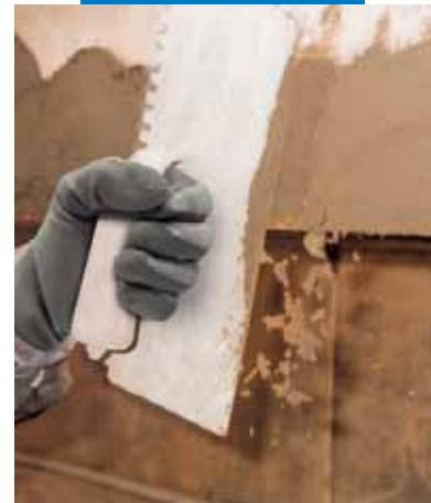
Instandsetzung einer Balkonbrüstung Reprofilierung des Mörtels
