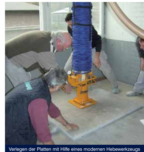
Verlegen der Platten mit Hilfe eines modernen Hebewerkzeugs
