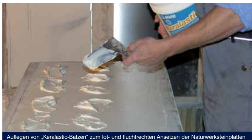
Auflegen von „Keralastic-Batzen“ zum lot- und fluchtrechten Ansetzen der Naturwerksteinplatten
