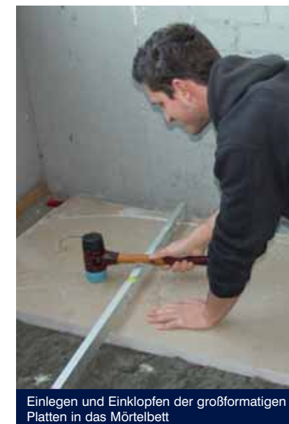
Verlegen der Platten ohne Hebewerkzeug
