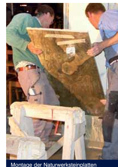
Montage der Naturwerksteinplatten
