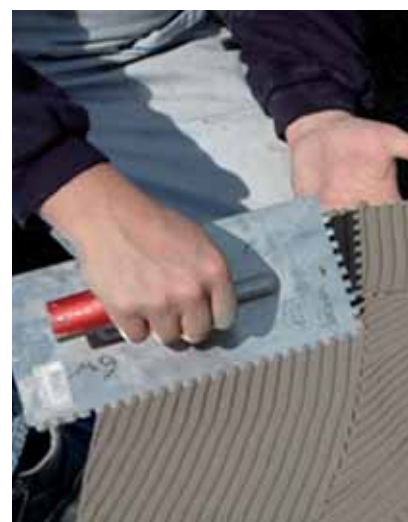
Auftrag des Spezialmörtels MAPEI ELASTORAPID auf die Rückseite des Belagsmaterials
