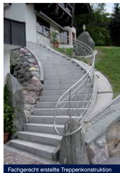
Fachgerecht erstellte Treppenkonstruktion
