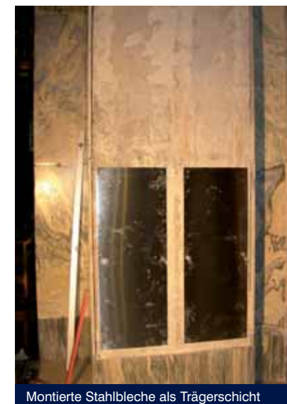
Montierte Stahlbleche als Trägerschicht
