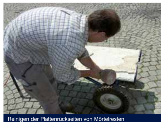
Reinigen der Plattenrückseiten von Mörtelresten
