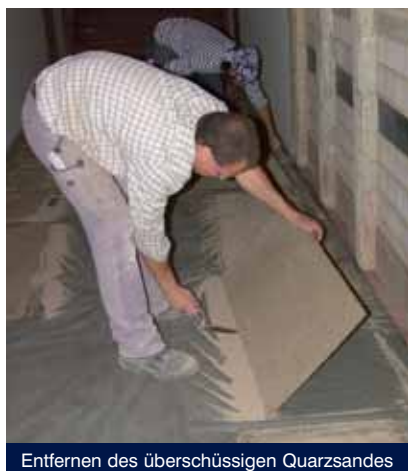
Entfernen des überschüssigen Quarzsandes
