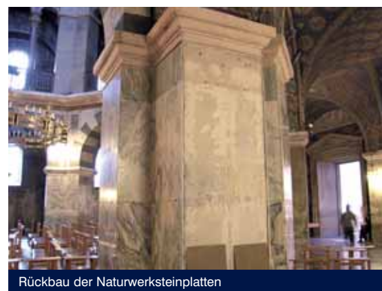
Rückbau der Naturwerksteinplatten
