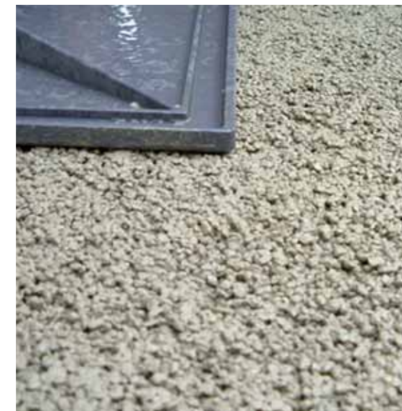
Oberflächenbearbeitung des Drainmörtels nach Einbau
