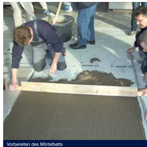
Vorbereiten des Mörtelbetts
