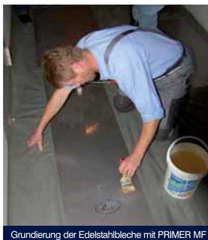
Grundierung der Edelstahlbleche mit PRIMER MF
