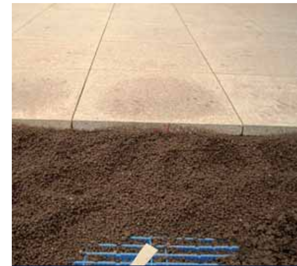
Einbau eines Drainestrichs, hergestellt aus Blähton und MAPEI MAPECEM
