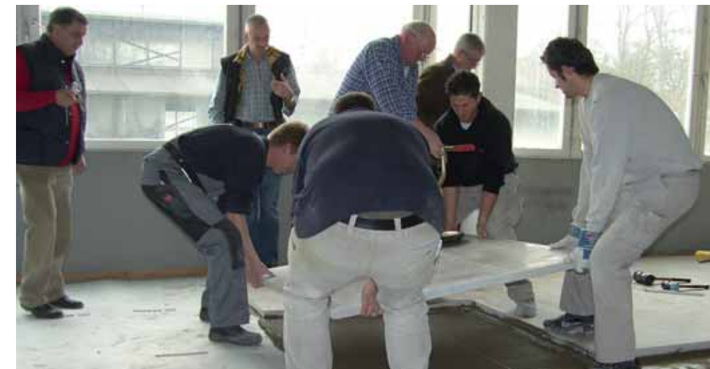
Verlegen der Platten ohne Hebewerkzeug
