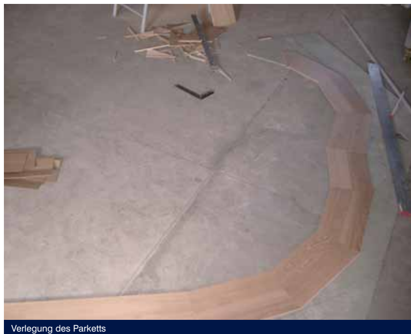
Verlegung des Parketts
