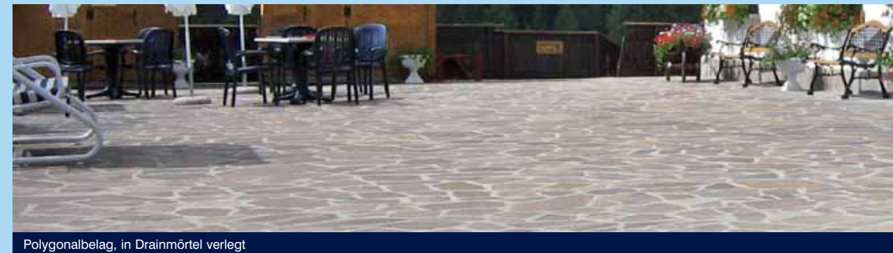
Polygonalbelag, in Drainmörtel verlegt
