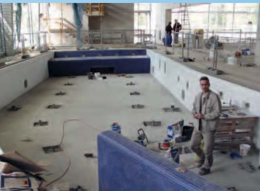
Mit MAPELASTIC abgedichtete Bodenflächen im Schwimmbecken
