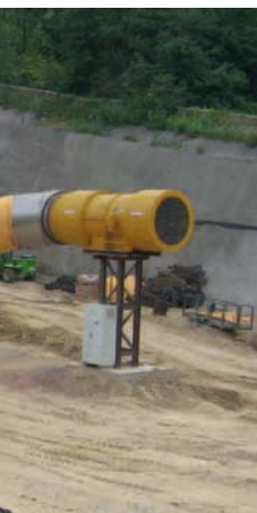
Bilder 1 bis 4: Im Spritzbeton für die Sicherung des Ausbruchs kam der Erstarrungsbeschleuniger MAPEQUICK AF D01/H zum Einsatz
