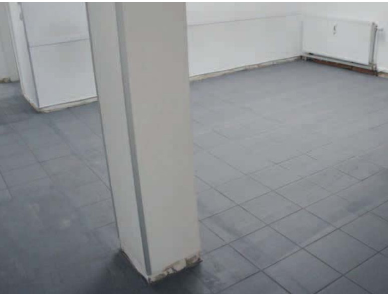
Altbelag vor Beginn der Renovierungsarbeiten
