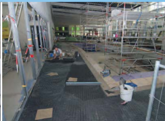
Verfugen des Mosaikbelags mit ULTRACOLOR PLUS
