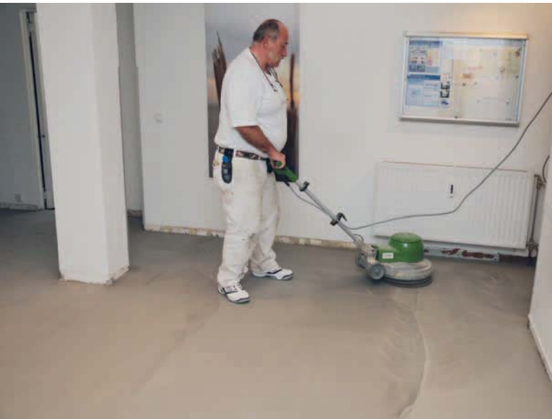
Abschleifen der Bodenspachtelmasse zur Herstellung einer planebenen Oberfläche
