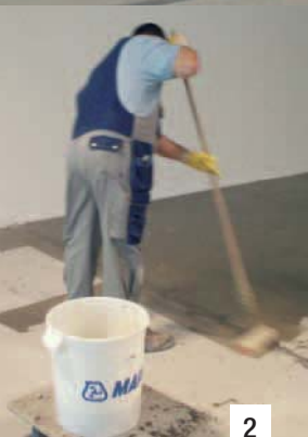
Bild 2. Fachgerechte Untergrundvorbereitung Bild 3. Für die Designbodenbeläge wurde der Universalklebstoff ULTRABOND ECO V4 SP eingesetzt
