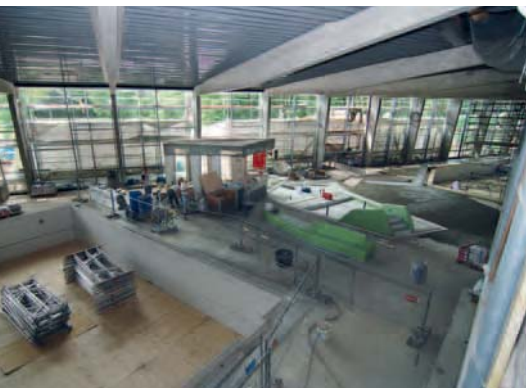
Blick in die Baustelle zum Zeitpunkt der Verlegearbeiten
