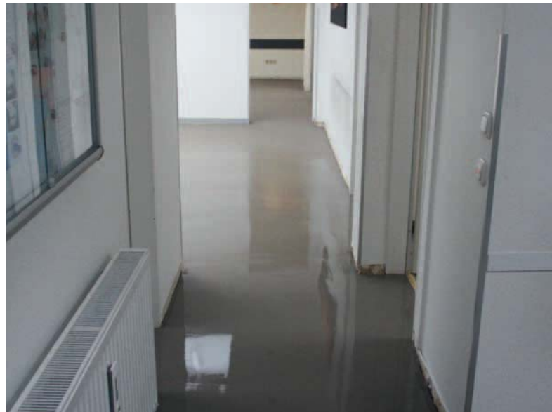
Höhennivellierung mit Bodenausgleichsmasse ULTRAPLAN
