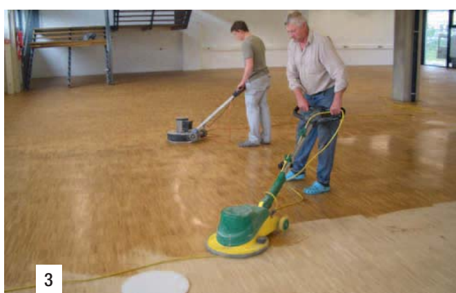
Bilder 1., 2. und 3. Einbringung des Eicheparketts und hochwertiges Finish mit MAPEI ULTRACOAT OIL CARE
