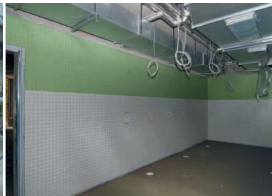
Mit MAPELASTIC abgedichtete Bodenflächen in den Duschanlagen
