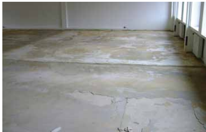
Mischuntergrund mit Zementestrich, Calciumsulfatestrich, zementärer Spachtelmasse, Estrichergänzungen sowie Klebstoffresten auf der Spachtelmasse
