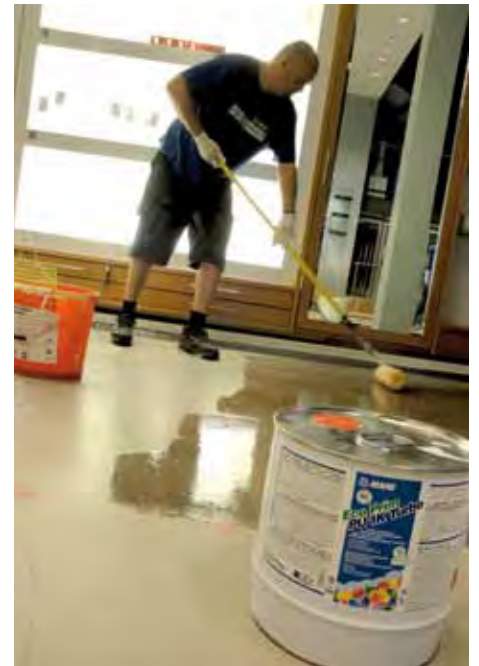
Grundierung des Estrichs
