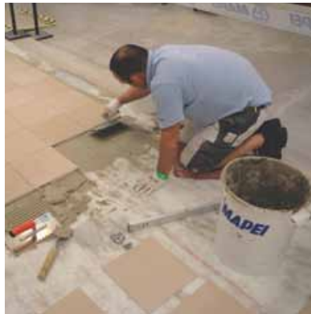
Sorgfältige Verlegung der Meissener Porzellan-Fliesen
