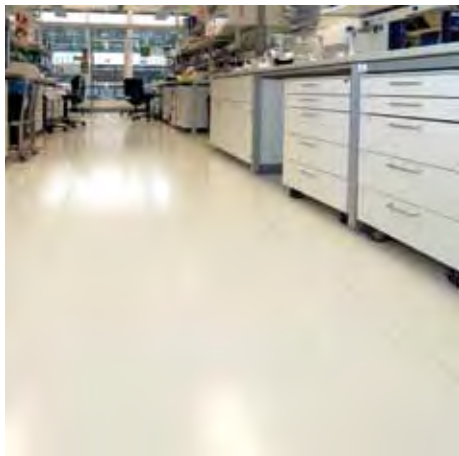
Ableitfähige Verlegung eines Synthese-Kautschuk-Belags in den Laboren
