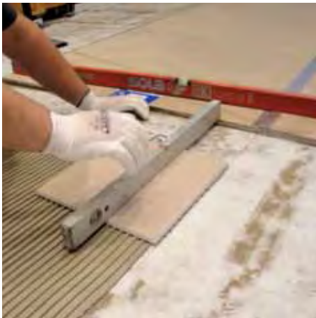
Vor der Verlegung wurde ein Höhenausgleich vorgenommen
