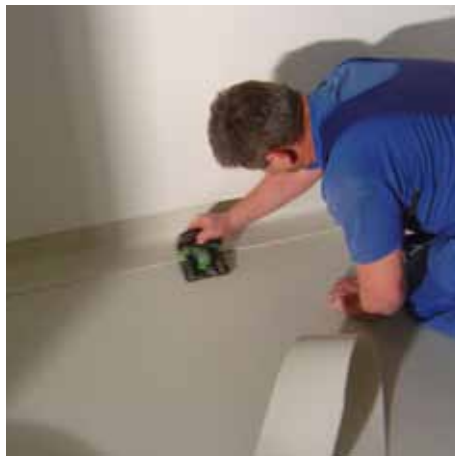
Die Verlegung erfolgte mit MAPEI-Systemprodukten
