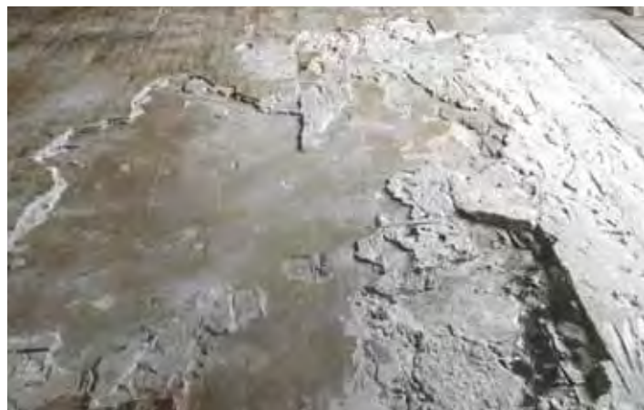
Altuntergrund mit diversen Spachtel- und Klebstoffschichten
