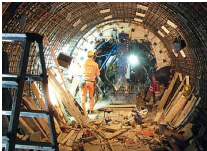
Herstellung der Bewehrung für Gewölbe (Verbindungstollen)
