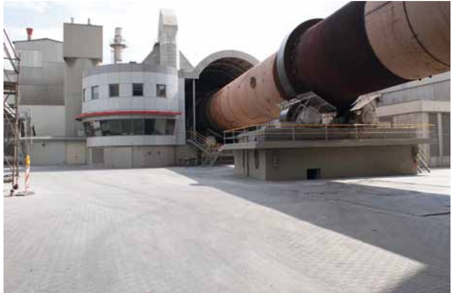
Bild oben rechts: Drehrohr und Leitstandsgebäude des Zementwerks in Karlstadt
