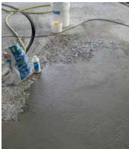
Profilierung der Brunnenscheibe mit PLANITOP FAST 330
