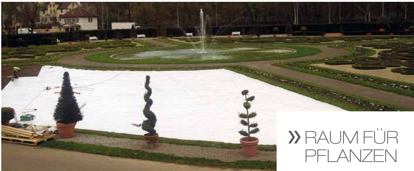
MAPEPLAN B 15 lose verlegt und mit automatischem Heißluftfön homogen verschweißt
