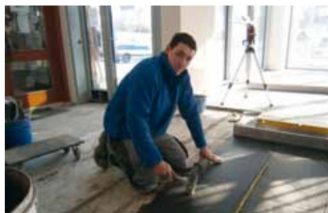
Verlegetechnik Arbeiten durch Pascal Illenberger (Steinmetz- & Bildhauer)
