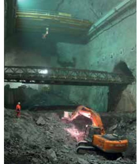
Schutterarbeiten in der Travokaverne
