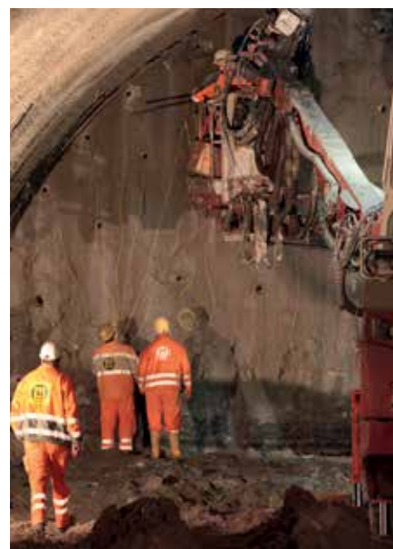
Vorbereitung der Sprengarbeiten an der Ortsbrust
