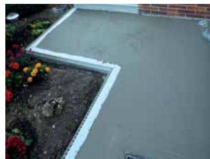
Mit Verbundabdichtung MAPELASTIC und Randprofilen vorbereitete Terrassenfläche
