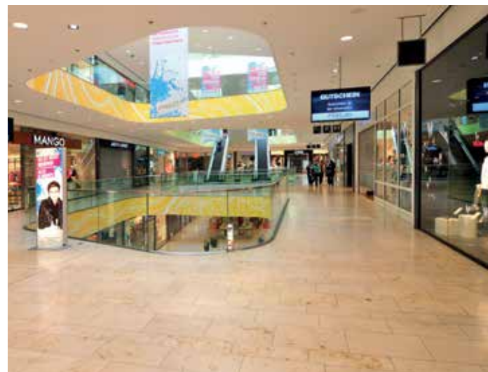
Verlegte Naturwerksteine mit MAPESTONE BASIC
