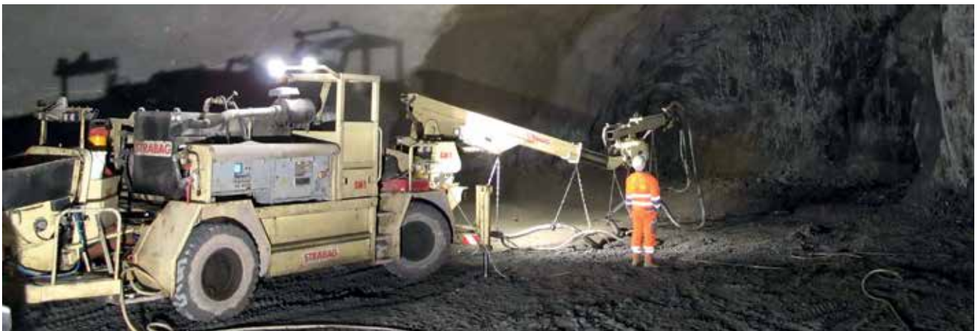
Vortrieb Zu- und Abwasserstollen
