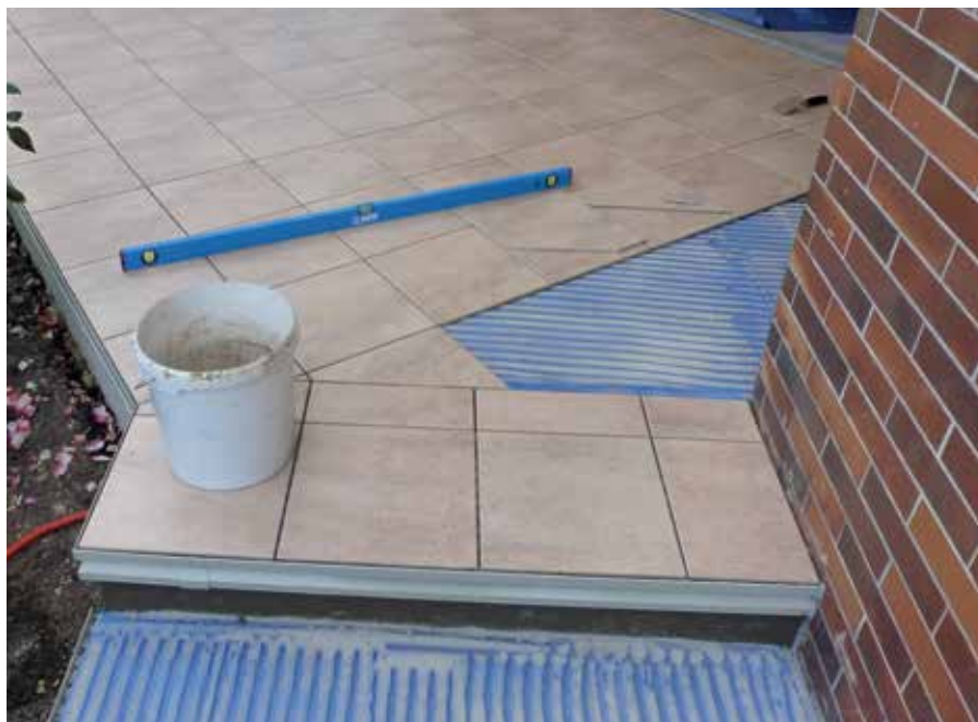
Verfügen eines mittels BDC-System verlegten Keramikbelages mit dem Hochleistungsfugenmörtel ULTRACOLOR PLUS
