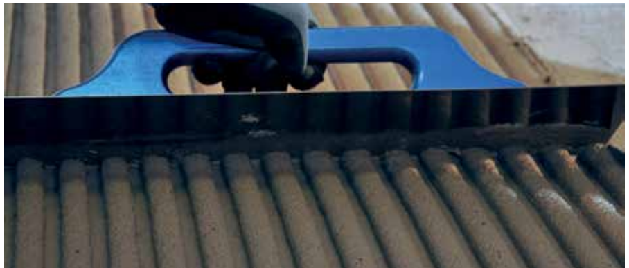
Aufziehen von Tragstegen mit PLANITOP FAST 330.
