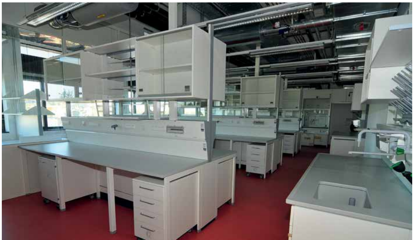
Zur Verlegung des Vinylbelags und bei der Ausführung von Hohlkehlen kamen in den Labors mit ULTRABOND ECO V4 SP und ULTRABOND ECO 380 zwei echte Profiprodukte aus der emissionsarmen ECO-Linie zum Einsatz.
