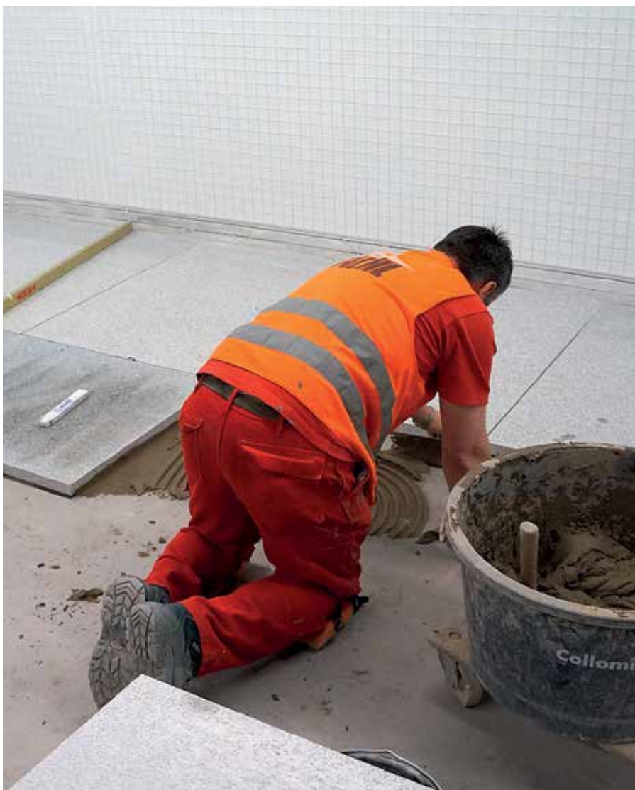
Die großformatigen Natursteinplatten stellen besondere Anforderungen an die Verlegequalität.
