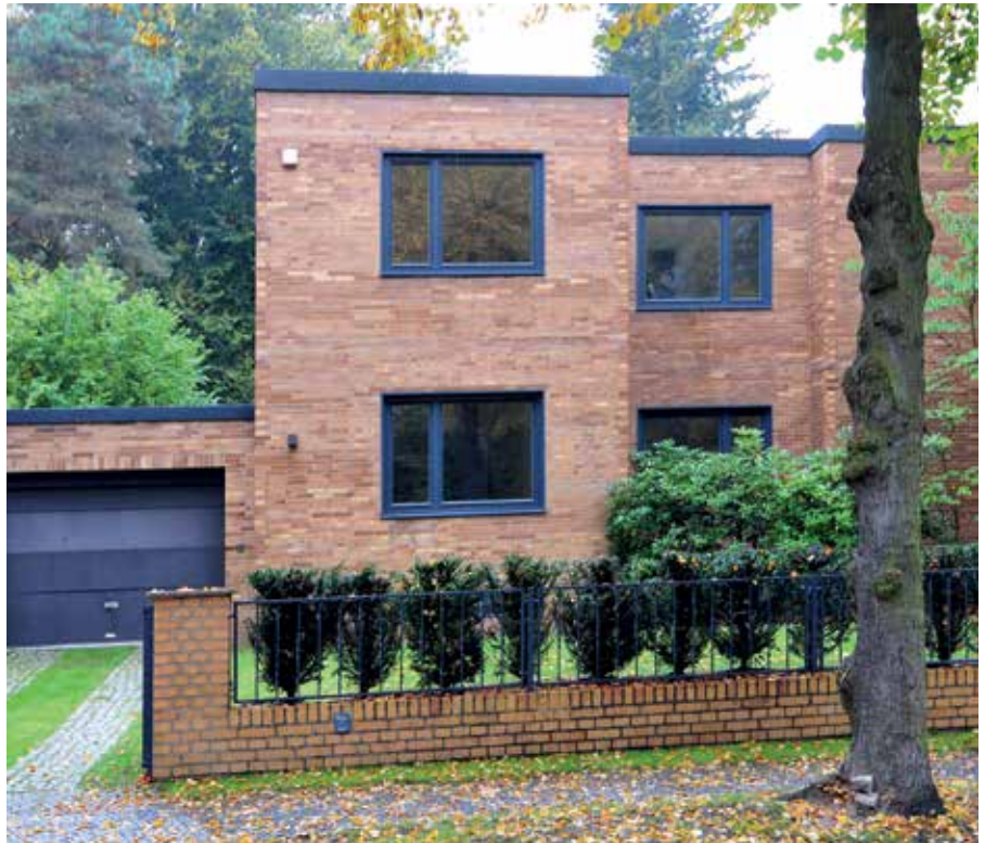
Die Villa aus den 1960er Jahren wurde entkernt und der Innenbereich komplett neu gestaltet.
