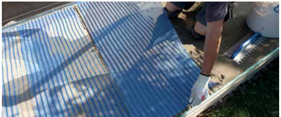
Das Maschennetz MAPENET 150 wird auf die frischen Tragstege aufgelegt und mittels Estrichwert in den frischen Mörtel eingebettet.
