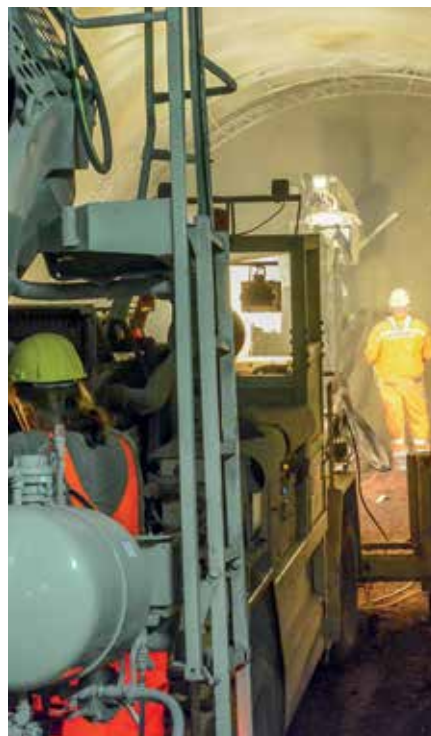
Einspritzen eines Gitterbogens im Vortrieb
