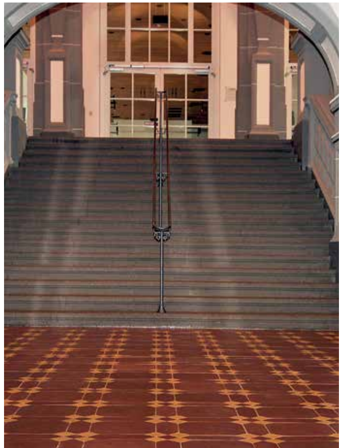
Da die Renovierungsarbeiten weitgehend bei laufendem Rathausbetrieb durchgeführt wurden, waren für die Bodenverlegung „schnelle“ Produkte mit hoher Sicherheit gefragt.
