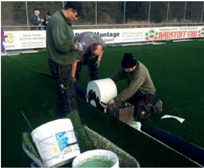
Die Kombination der beiden MAPEI Systemprodukte ULTRABOND TURF STARS VERDE und ULTRABOND TURF TAPE 300 gewährt eine dauerhafte Verklebung des Kunstrasenbelages.
