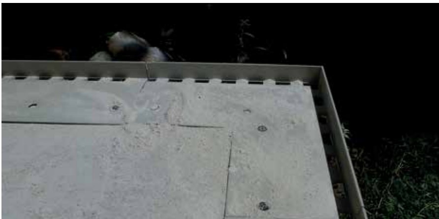
Aluminium-Profil mit zwei Entwässerungsebenen zur Ableitung der Feuchtigkeit.
