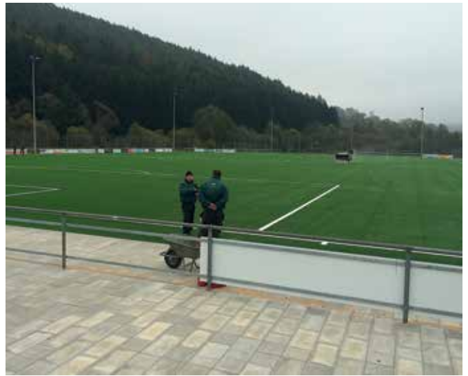
Beim TuS Frammersbach wurde eine rund 7.000 m 2 große Kunstrasenfläche nach dem absolut neuesten Stand der Technik installiert.
