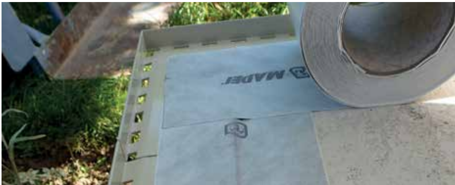
Verkleben des Dichtbands MAPEBAND SA BUTYL auf Schiene und Estrich.
