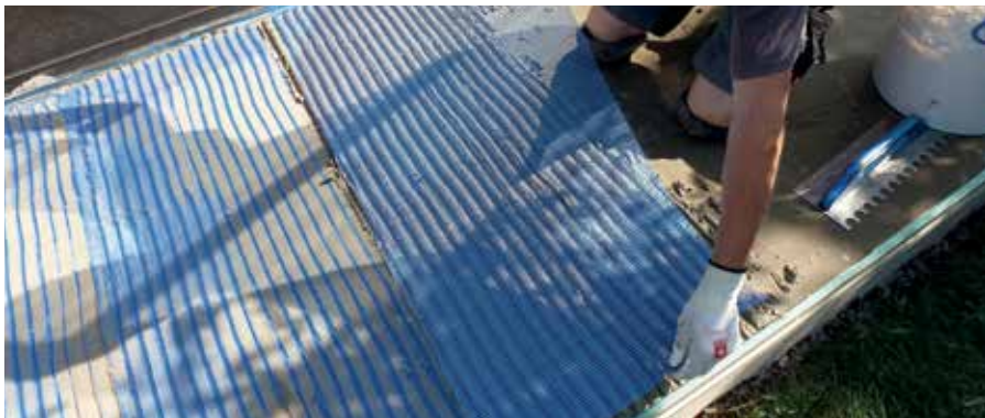
Das Maschennetz MAPENET 150 wird auf die frischen Tragstege aufgelegt und mittels Estrichschwert in den frischen Mörtel eingebettet.
