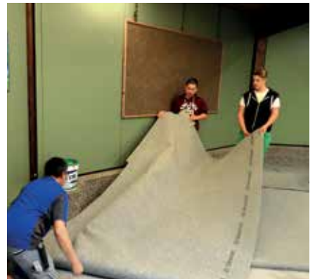
Gemeinsam ging es an die Verlegung der Kugelgarn-Bahnenware des Herstellers Fabromont.
