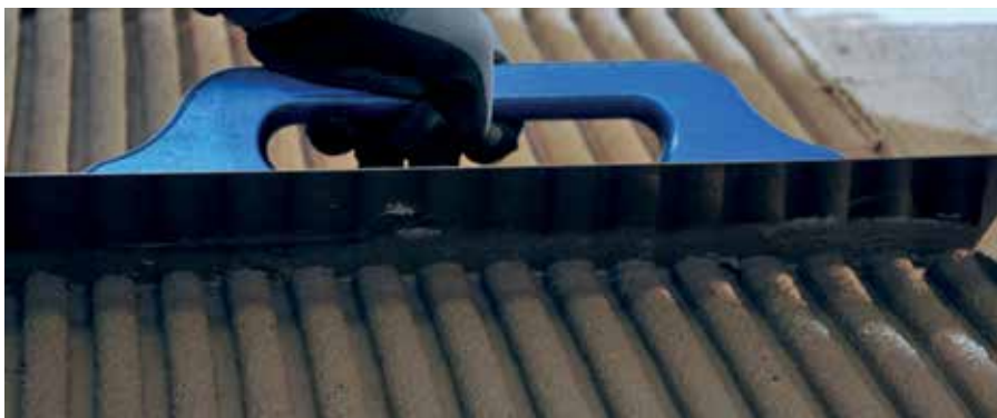
Aufziehen von Tragstegen mit PLANITOP FAST 330.
