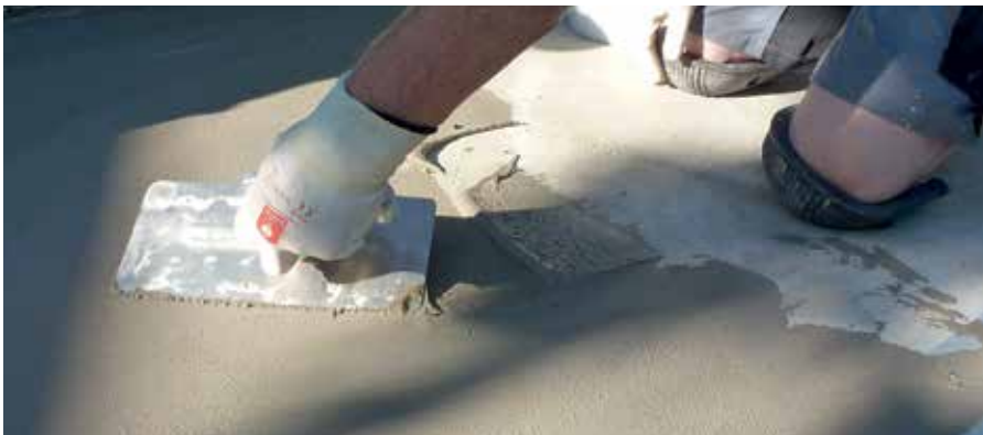
Abdichtung der Fläche mit der zweikomponentigen, zementären Verbundabdichtung MAPELASTIC.
