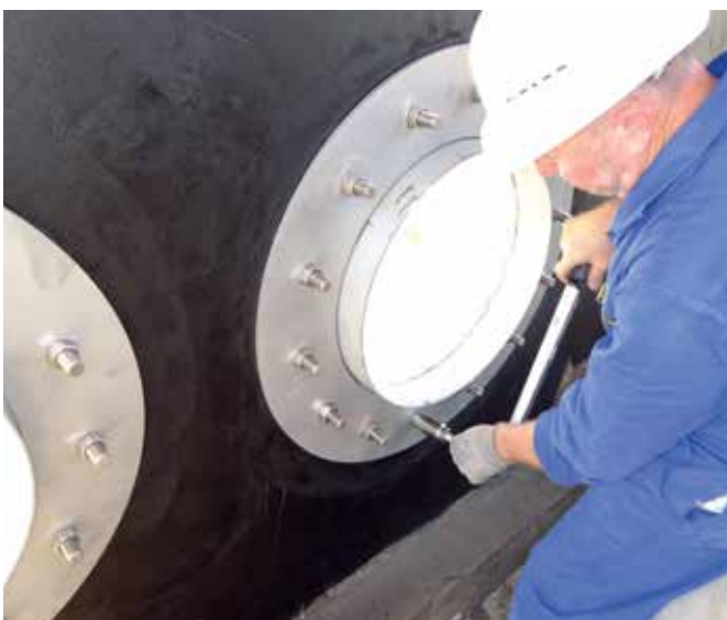
Als Bindeglied zwischen der Flächenabdichtung und den Medienanschlüssen kamen bereits bei der Wandherstellung einbetonierte oder nachträglich auf der wasserbelasteten Betonoberfläche montierte Los-Festflanschkonstruktionen zum Einsatz.
