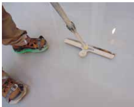
Kreieren der Wolkigkeit mittels flach aufgelegter Raket.
