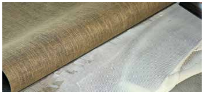
Bahn für Bahn wird das Linoleum circa 2 cm überlappend verlegt.
