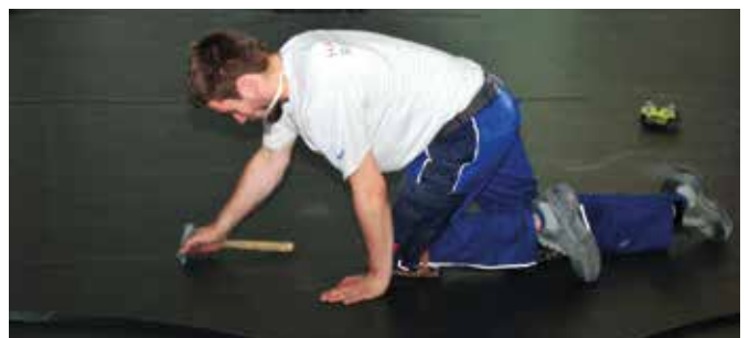
Das Abdichten der Nähte mit Schmelzdraht erfolgt erst nach dem Abbinden des Klebstoffes.
