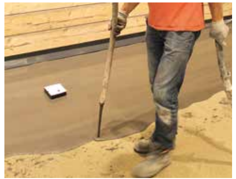
Die selbstverlaufende Bodenspachtelmasse ULTRATOP lässt sich leicht per Hand oder Maschine auftragen.
