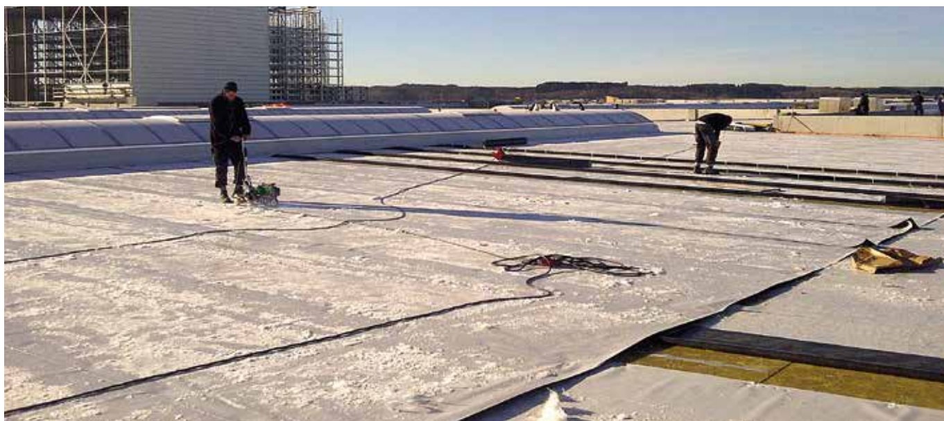
MAPEPLAN® M 20 und MAPEPLAN® B 20 sorgen bei der riesigen Dachfläche des Lagergebäudes für eine sehr sichere und funktionierende Abdichtung und Begrünungsbasis.
