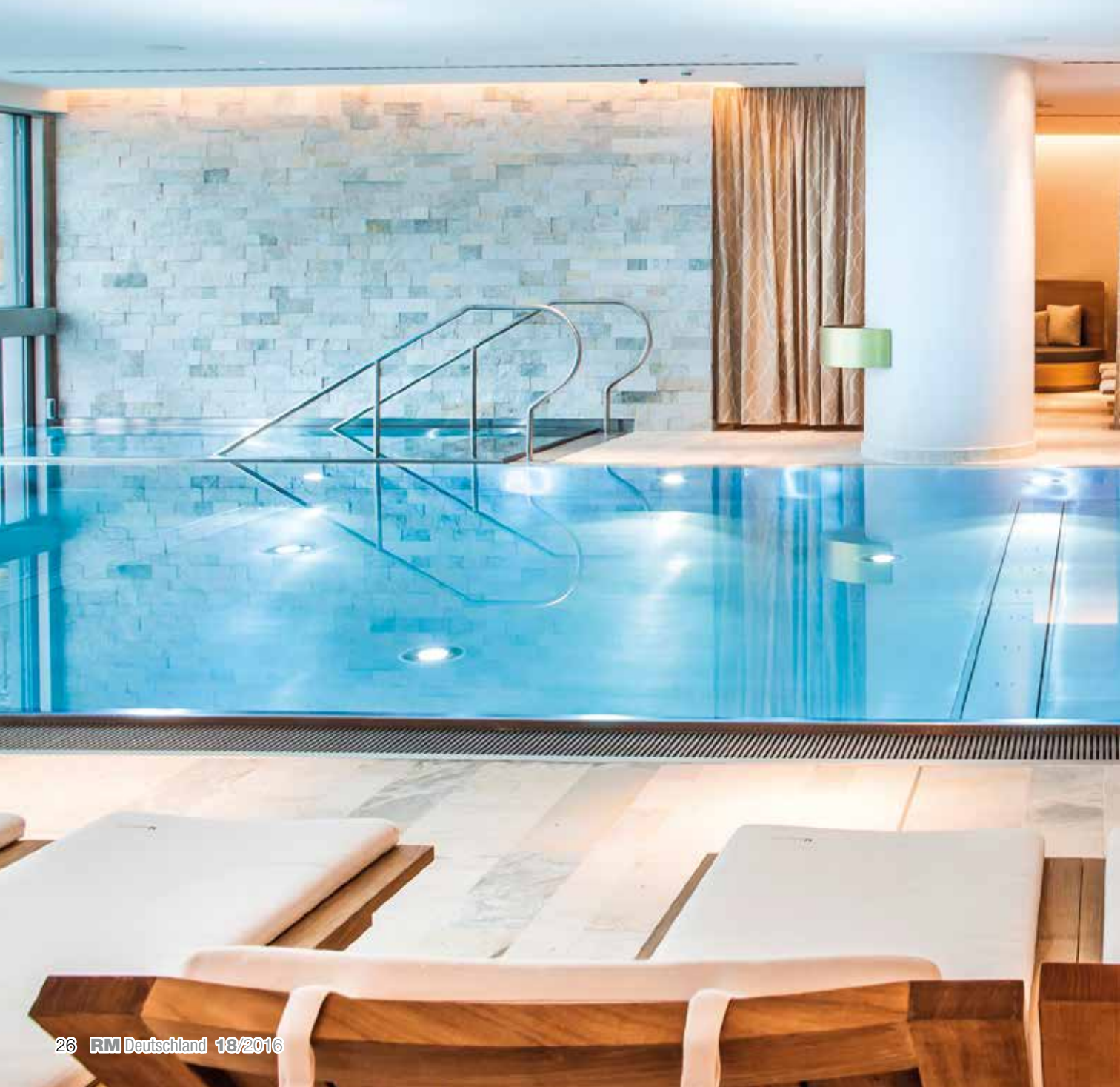
Verlegt wurden die Natursteine in den durch Feuchte belasteten Bereichen auf einer Reaktionsharz-Verbundabdichtung mit dem Spezial-Verlegemörtel ELASTORAPID.
