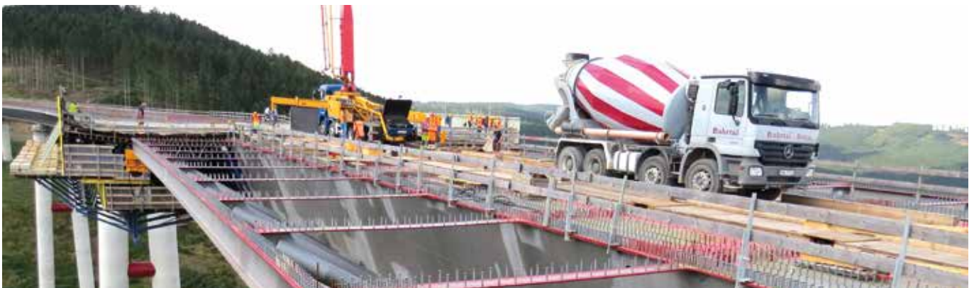
Die Fahrbahnplatten werden im Pilgerschrittverfahren in 115 Metern Höhe hergestellt.
