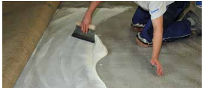
Zügig wird der Kleber mit einer Zahnpachtel auf die Fläche aufgebracht.
