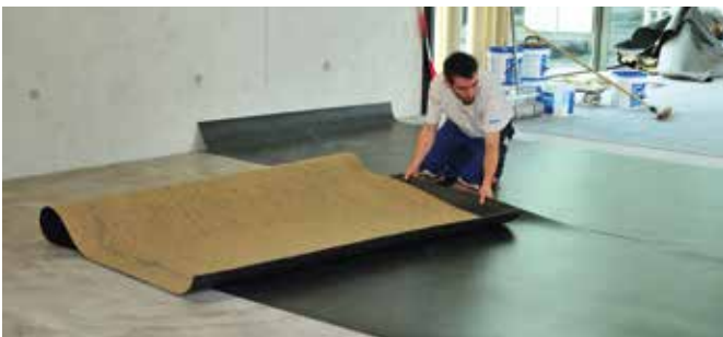
Voraussetzung für die sichere Verlegung ist eine vollflächige Benetzung der Belagsrückseite.
