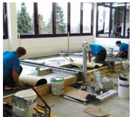
Neben dem Grundieren, Ausgleichen und Nivellieren des Untergrundes bestand die Aufgabe in der Verlegung eines Bodenbelags mit Intarsien und Sockelleisten.
