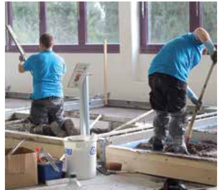
Auf der zuvor erstellten Dämmschicht wurde ein Schnell-Estrich als Tragschicht aufgebracht.
