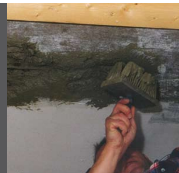
foto 6 Applicazione a pennello di SEWAMENT 3 PRIMER
