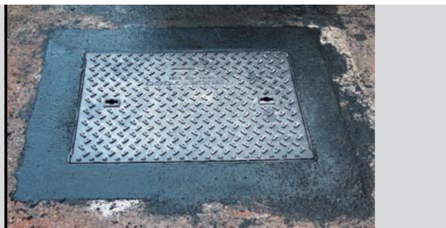
foto 13 Tombino fissato alla pavimentazione con MAPEGROUT SV
