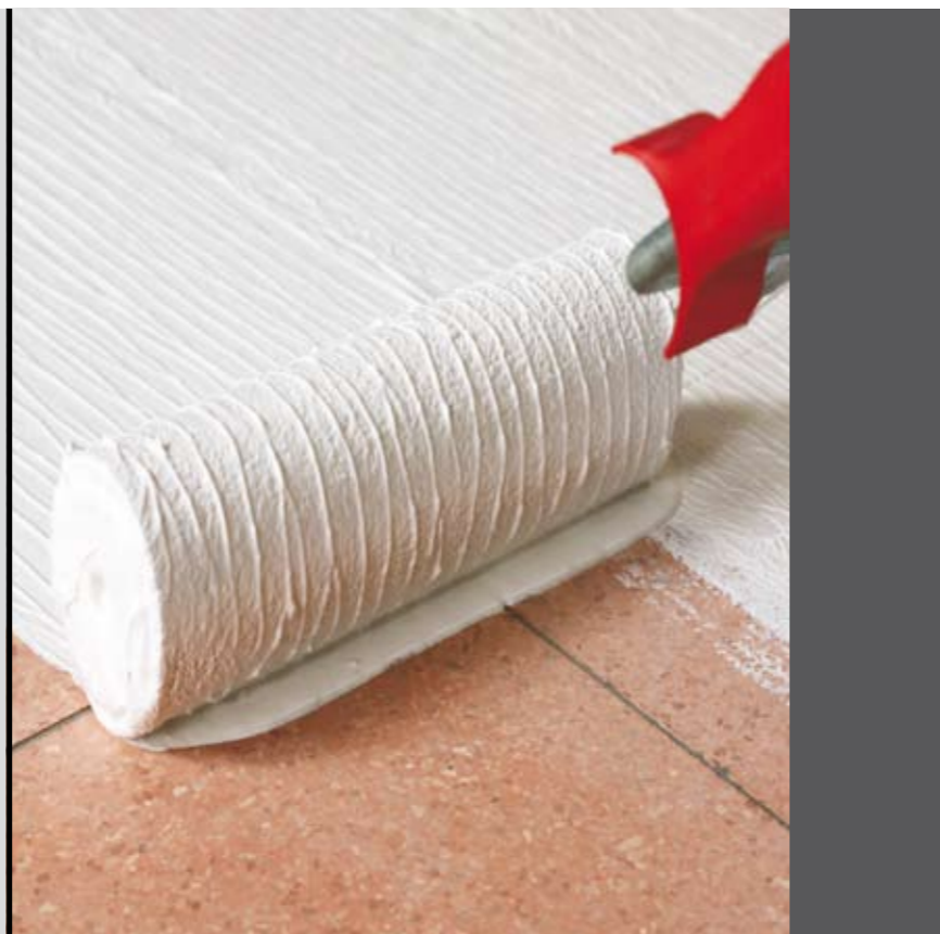
foto 16 Applicazione a rullo del primer TRIBLOCK P
