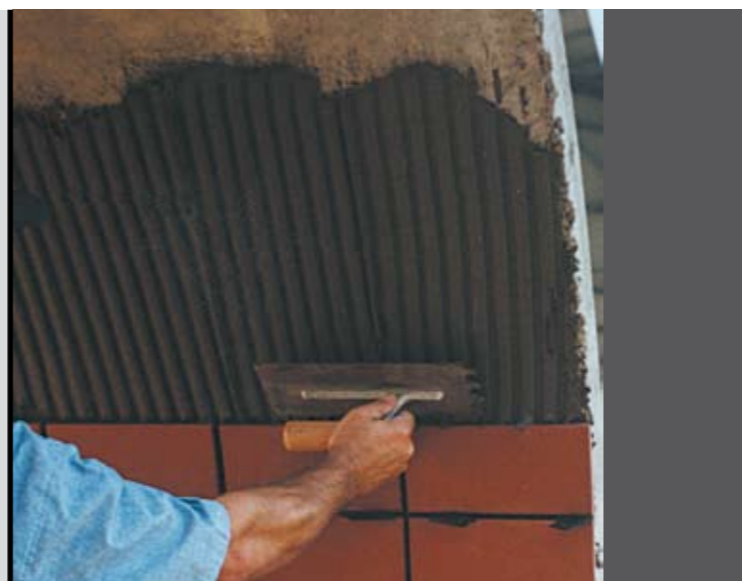
foto 4 Posa di piastrelle di ceramica con SEWAMENT 1
