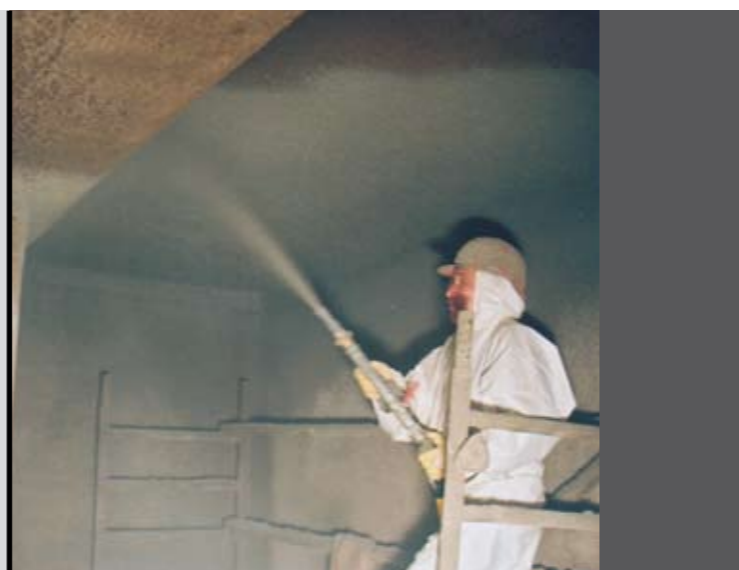
foto 7 Applicazione a spruzzo di SEWAMENT 10 in un collettore fognario
