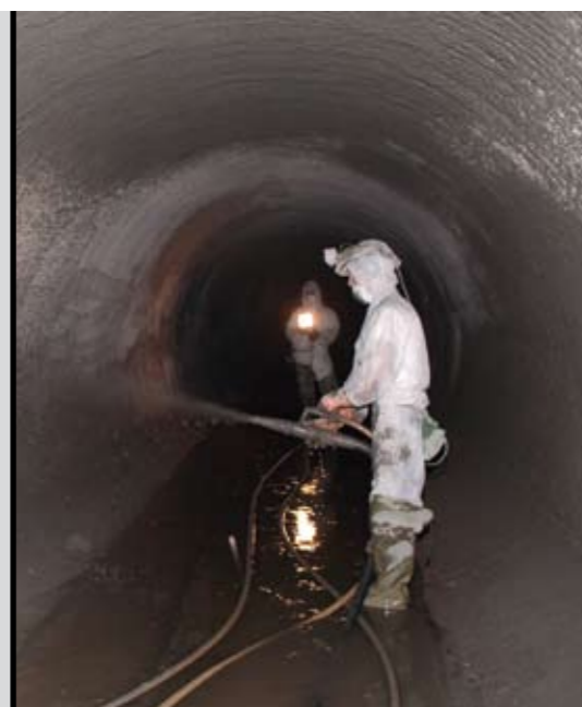
foto 10 Applicazione a spruzzo di MAPEGROUT FMR + FIBRE FF , in una condotta fognaria
