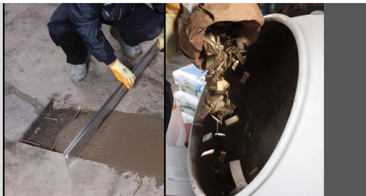
foto 14 Ripristino di una platea in calcestruzzo con MAPEGROUT SV FIBER + FIBRE R38
