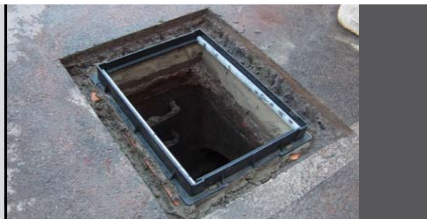
foto 12 Preparazione al ripristino di un tombino
