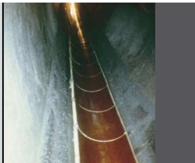
foto 8 Pareti di una condotta ripristinate con SEWAMENT 40
