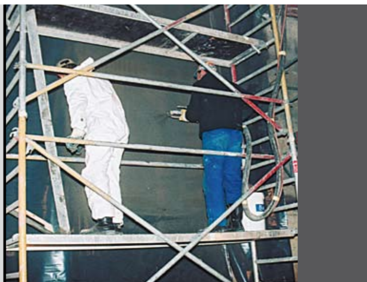
foto 9 Applicazione a spruzzo di SEWAMENT 100
