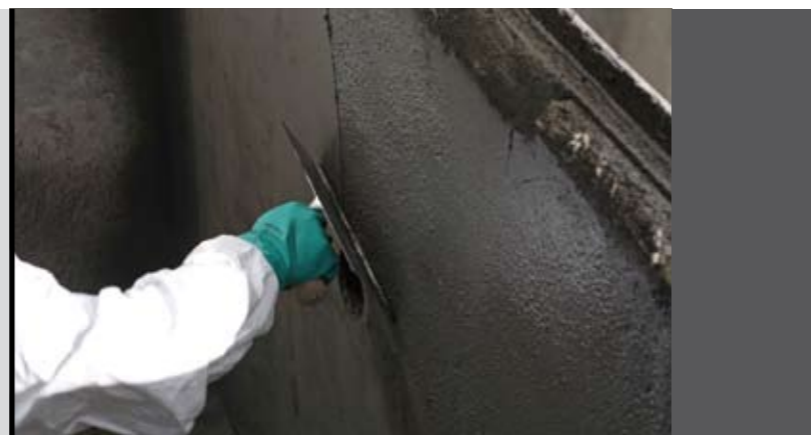
foto 18 Regolarizzazione con spatola metallica di TRIBLOCK FINISH
