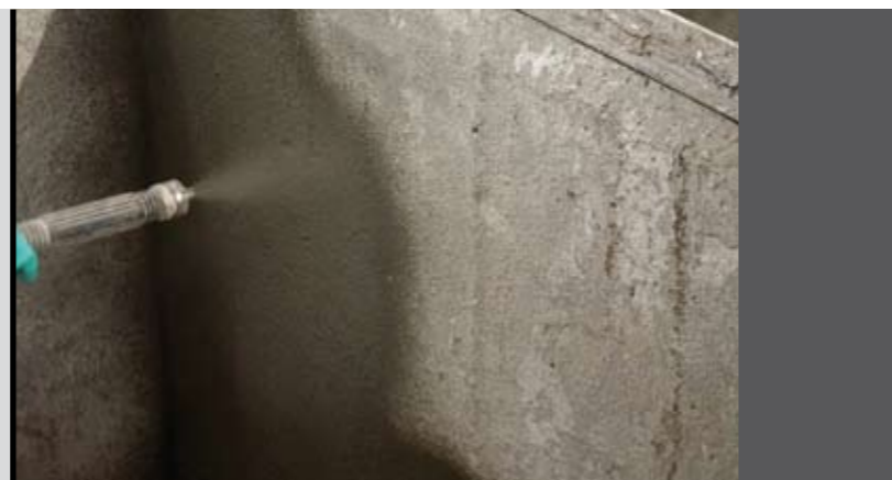
foto 17 Applicazione a spruzzo di TRIBLOCK FINISH
