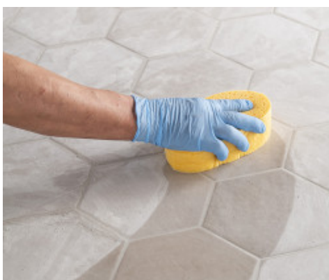
Curatarea si finisarea rosturilor cu un burete din celuloza dura
