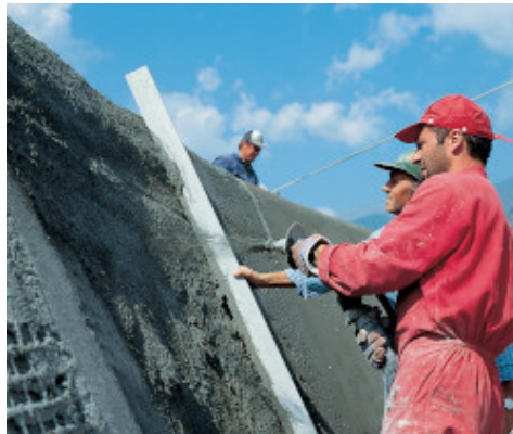
Aplicarea prin pulverizare a produsului Mapegrout T40
