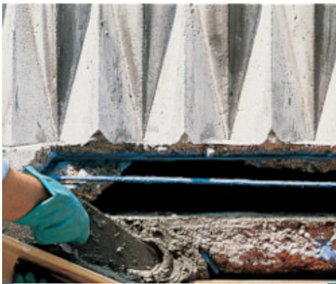
Repararea unui balcon cu Mapegrout T40
