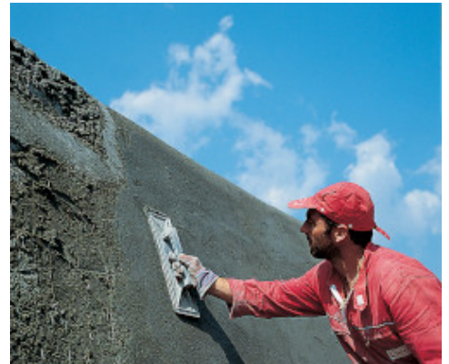
Finisarea Mapegrout T40
