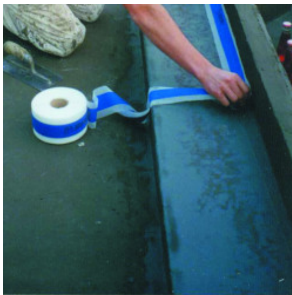
Un exemplu de impermeabilizare Mapeband a unui colt între fundul și o parte laterală a unei căzi de baie
