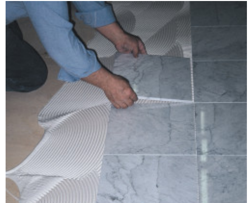
Montaj marmura de Carrara pe suport din lemn cu Keralastic alb
