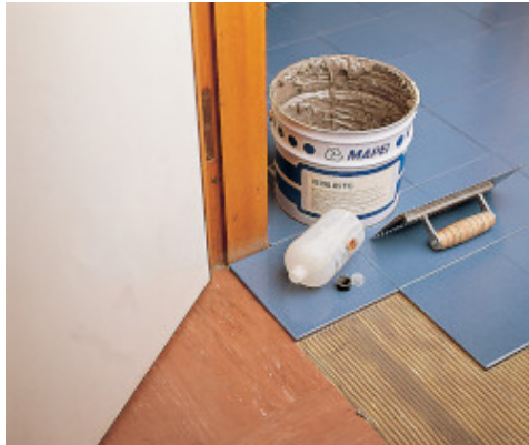
Lipire placi ceramice pe pardoseala din covor PVC
