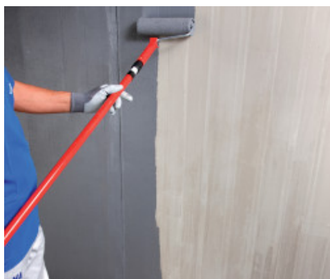
Aplicarea Eco Prim Grip Plus pe beton cu un trafalet
