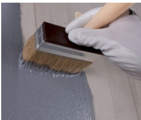
Aplicarea Eco Prim Grip Plus pe beton cu o pensula
