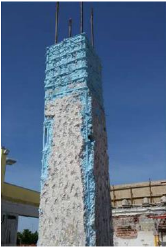
Figura 6.1: Preparación de la superficie.
