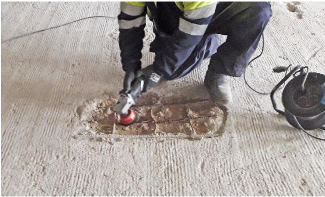
Figura 6.1: Tratamiento de armaduras que quedan a la vista tras la preparación del soporte mediante hidro-escarificado en este caso.
