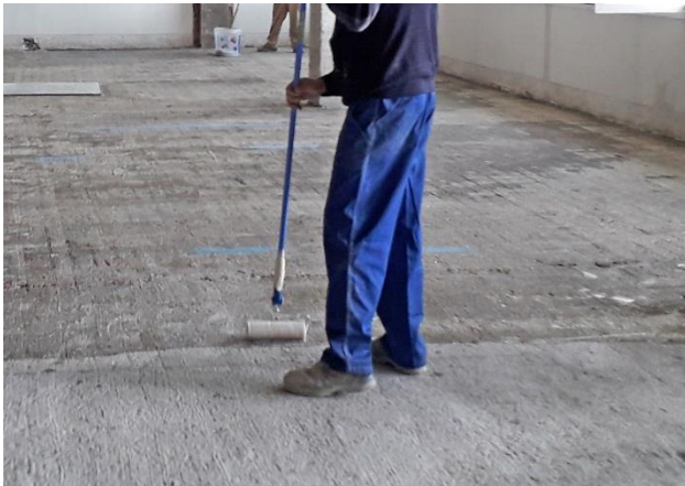
Figura 6.2: Aplicación de Primer 3296 en el soporte.
