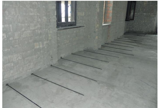
Figura 6.3: Disposición de armaduras en el perímetro.
