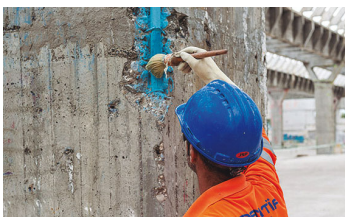
Obra Plataforma Logística Mayoral (Málaga). Producto utilizado: Mapefer 1K .
