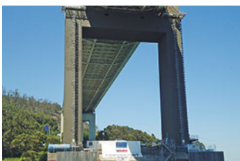
Obra Puente Rande (Vigo). Producto utilizado: Mapelastic .
