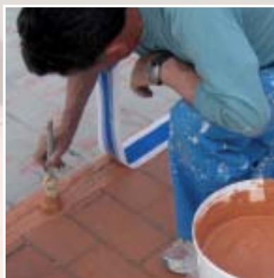
Tratamiento de las juntas de una terraza con Mapeband
