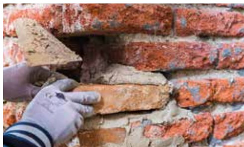
Reconstrucción de porciones de albañilería.
