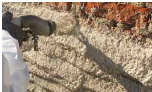
Reconstrucción de un revoque existente (aplicación con máquina rovocadora).
