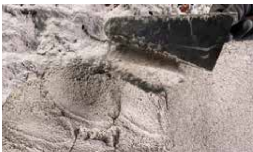
Reconstrucción de un revoque existente (aplicación con paleta).
