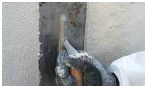
Enlucido de una superficie existente en presencia de vieja pintura.
