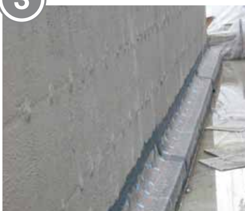
Impermeabilización de muros de contención
