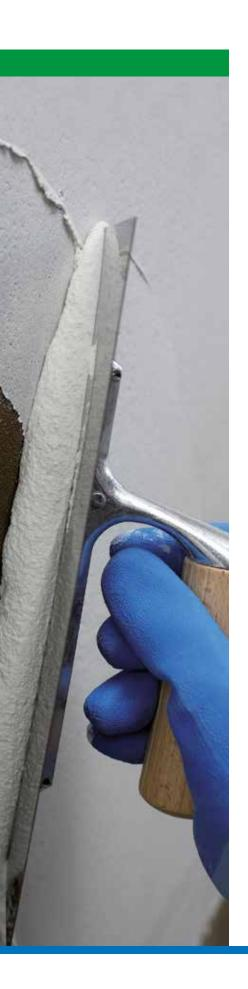
adecuado para obras «cara vista». Clasificado UNE EN 1504-2 revestimiento (C) principios MC e IR.
