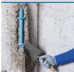
Mortero cementoso tixotrópico estructural de clase R4, fibrorreforzado, de fraguado rápido y retracción compensada, para la reparación y el enlucido del hormigón, aplicable en un espesor comprendido entre 3 y 40 mm, en una sola capa.
