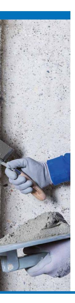
para el saneamiento del hormigón donde se requiera una elevada ductilidad. Clase R4 según la UNE EN 1504-3.
