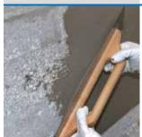
Mortero cementoso de nivelación. fibrorreforzado, de fraguado rápido, para interiores y exteriores, en pared y pavimento, para la regularización con espesores de 3 a 30 mm.
