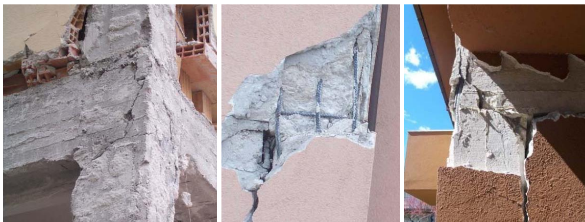
Figura 18: Lesiones en pilares y nudos
