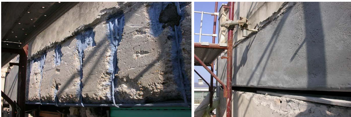
Figura 25: Preparación del soporte
