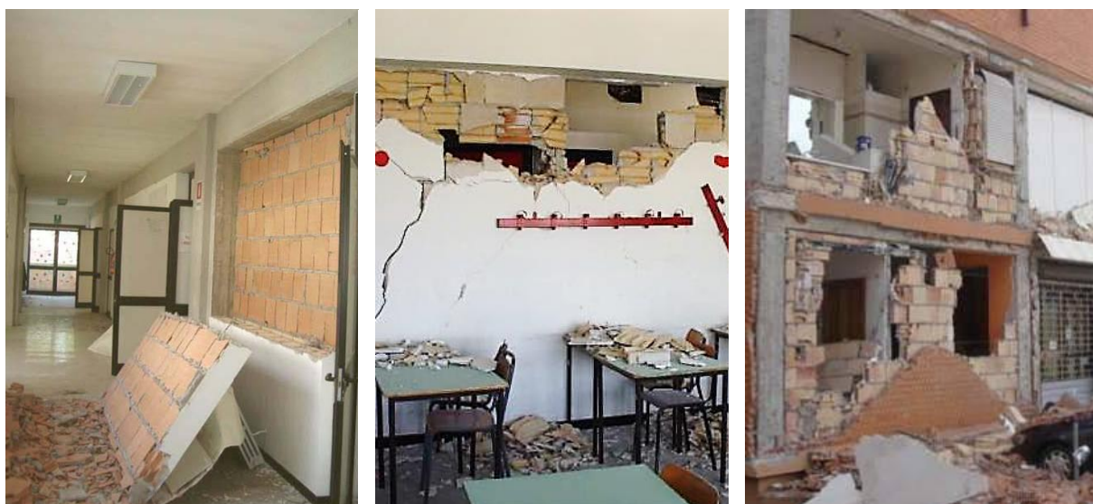
Figura 33: Vuelco de cerramientos y particiones
