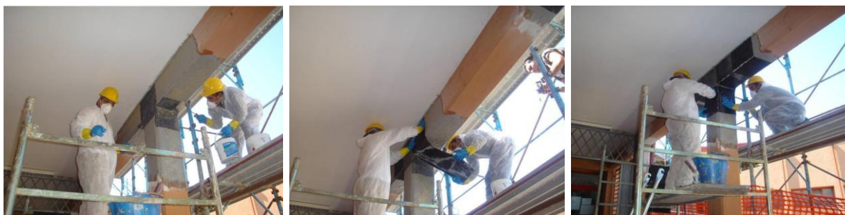
Figura 26: Aplicación del adhesivo y colocación del tejido
