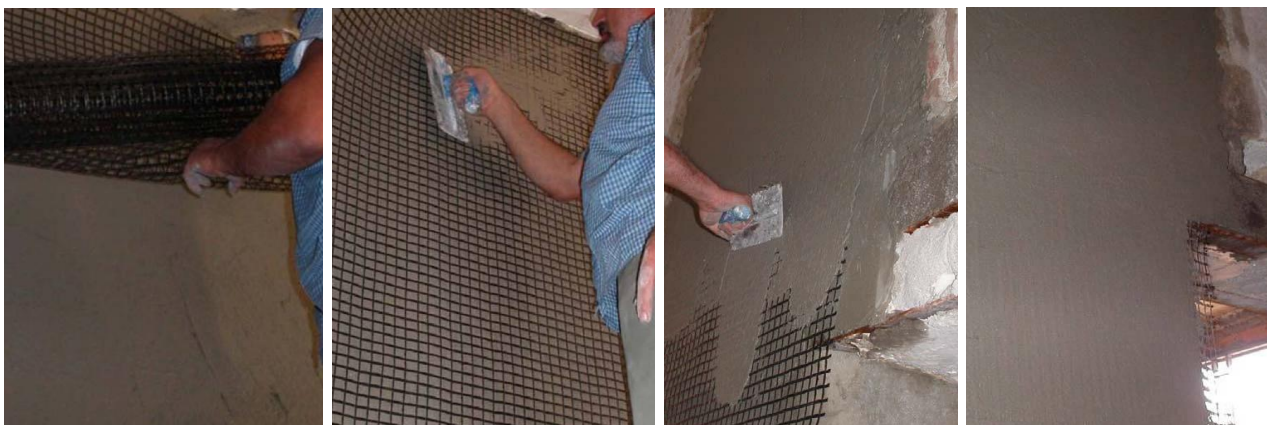
Figura 28: Puesta en obra
