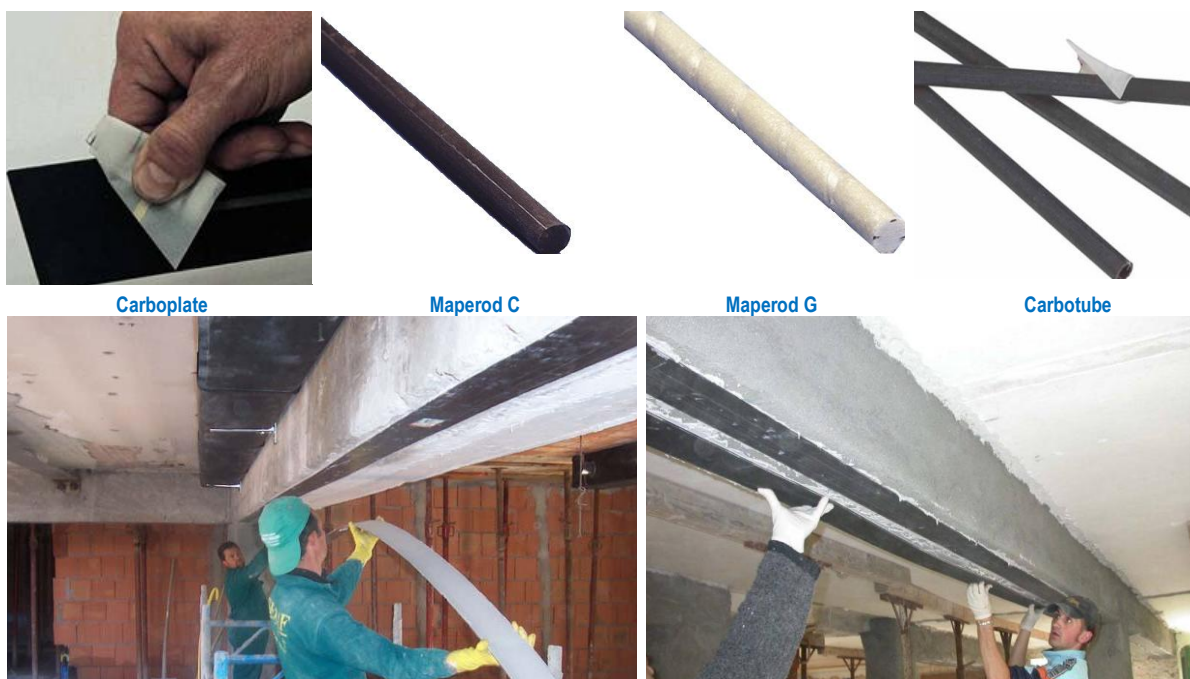
Figura 23: Adhesivos, láminas y barras. Colocación del sistema
