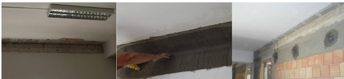
Figura 32: Aplicación del mortero la malla
