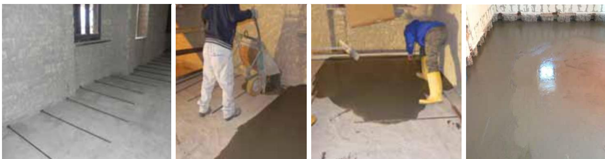
Figura 29: Disposición del armado y vertido del mortero
