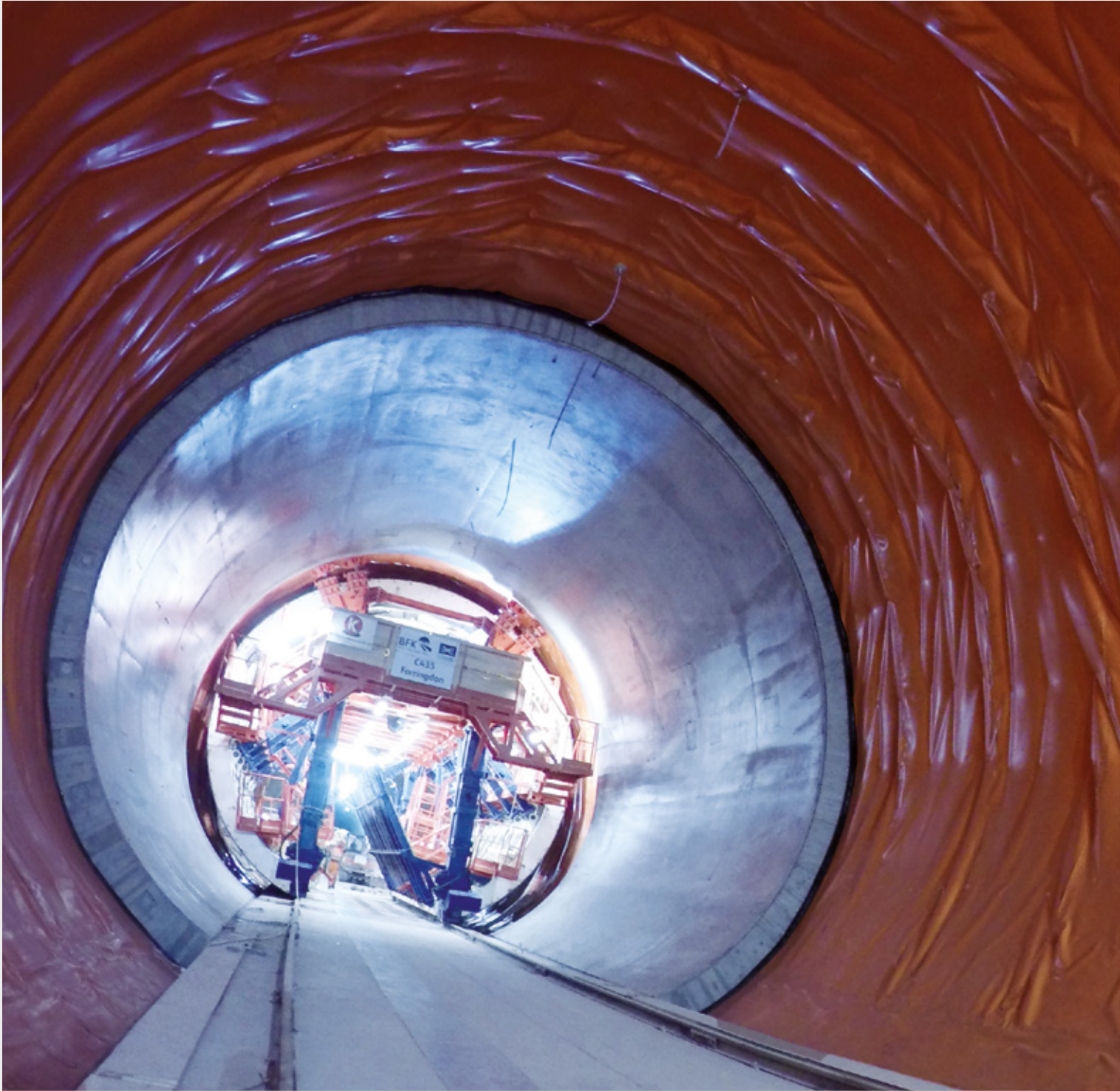
PROYECTO CROSSRAIL - Estación de Metro Farringdon - Londres (GB)
