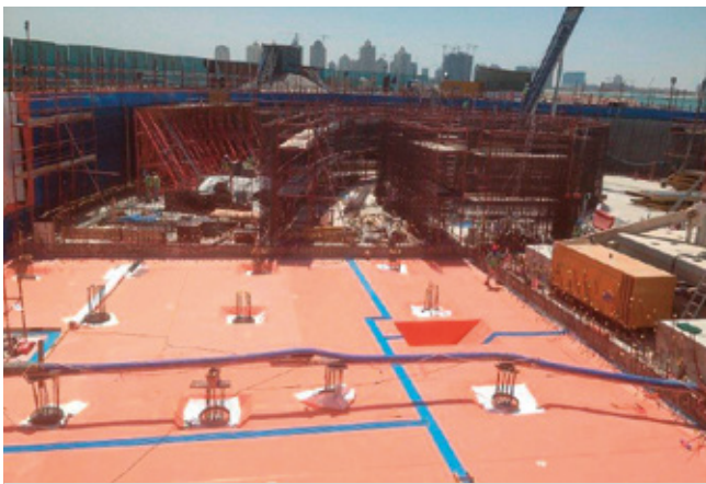
Cimentación (Pearl Maison - Doha - Qatar)
