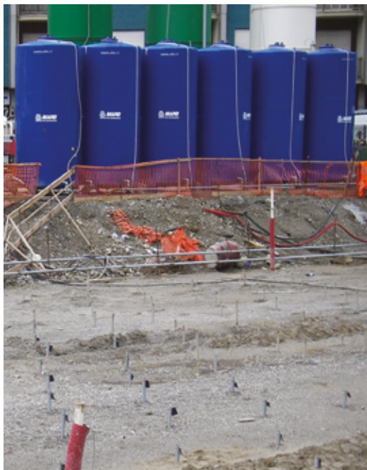
Metro de Torino, Italia: impermeabilización de losa de fondo
