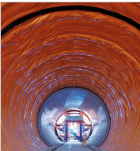
ESTACIÓN DE METRO FARRINGDON, Crossrail Londres (GB)
