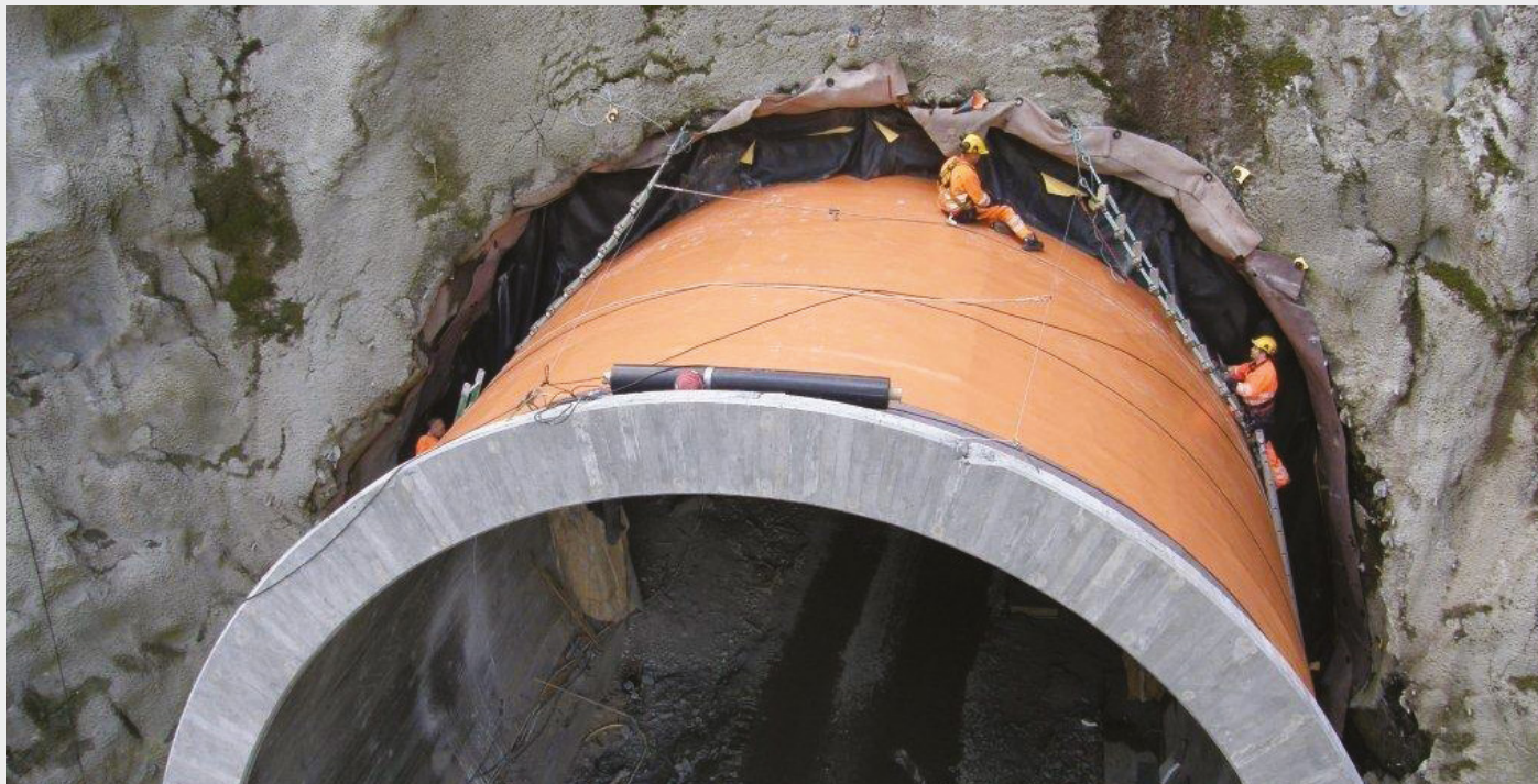
Hauge Túnel - Istak Lonevag - Noruega
