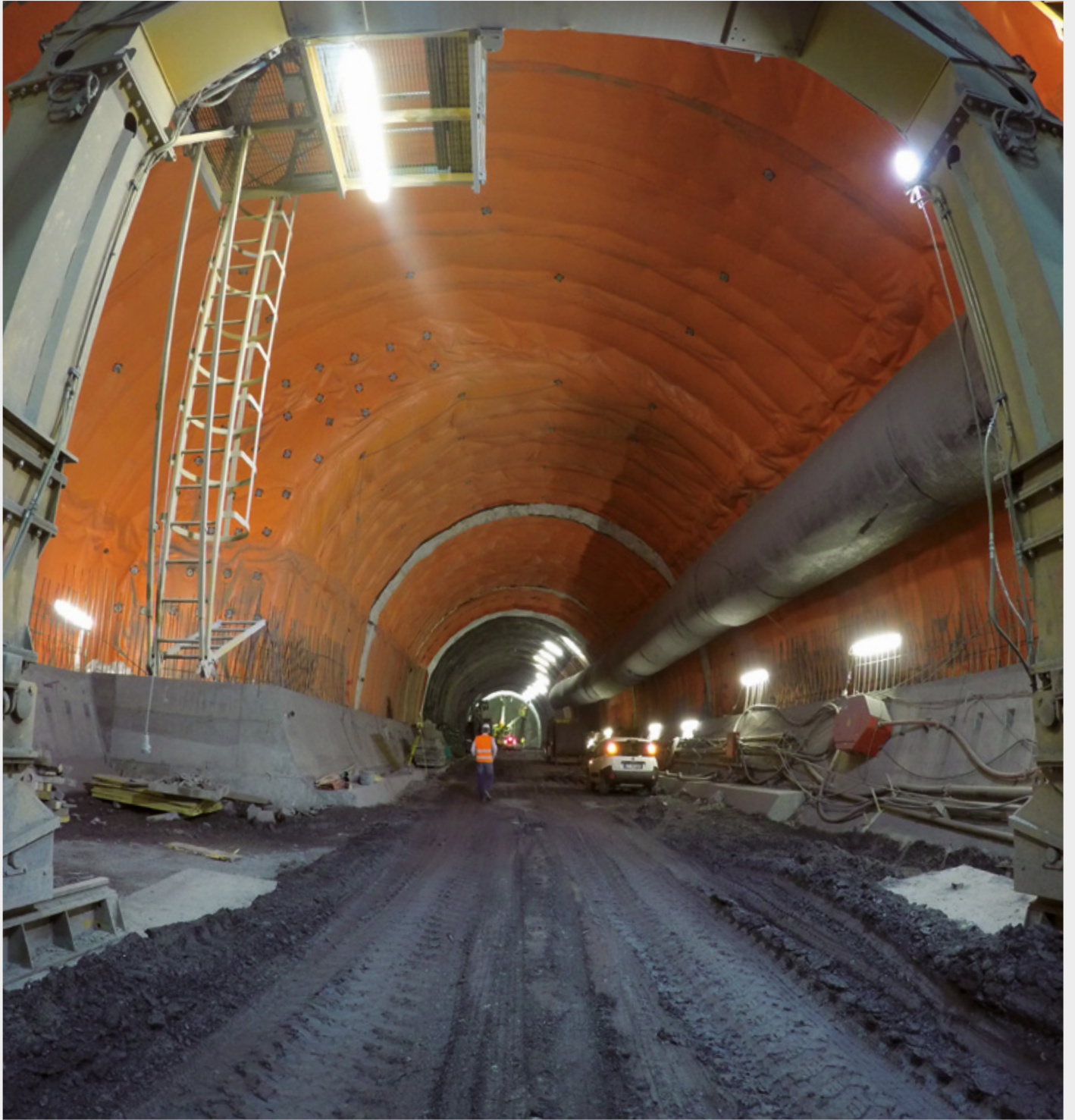
TÚNEL PARA TREN DE ALTA VELOCIDAD MILANO-GENOVA - Italia
