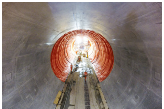
Estación de Metro (Farringdon - Crossrail Londres (UK))
