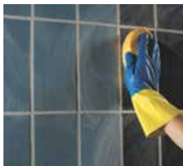
Limpieza y acabado con esponja dura de celulosa
