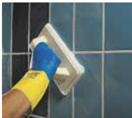
Kerapoxy CQ se emulsiona con agua, utilizando una esponja de "Scotch Brite®"
