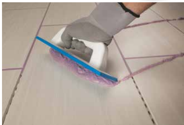
Aplicación de Kerapoxy CQ con llana Mapei
