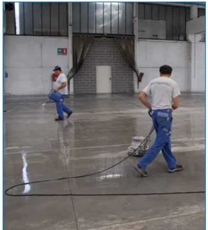
**Impregnante tixotrópico, en base silanos, exento de disolventes, en dispersión acuosa para el tratamiento hidrófugo del hormigón.**
