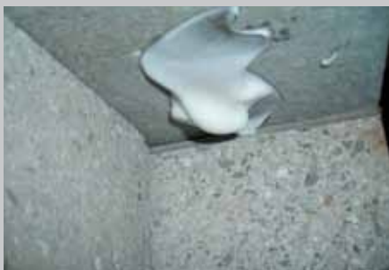
Aplicación en techos
