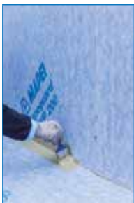
Aplicación de Mapeguard WP Adhesive para el encolado de Mapeguard ST
