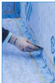
Aplicación de Mapeguard ST
