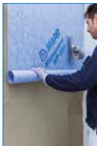
Aplicación de Mapeguard WP 200
