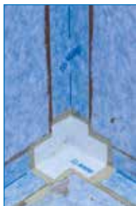
Detalle de la impermeabilización de una esquina con Mapeguard IC
