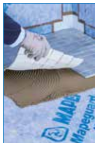
Instalación de mosaico vítreo sobre Mapeguard WP 200
