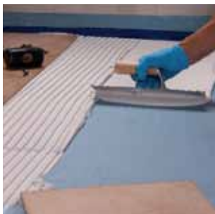
Colocación de las baldosas después de 4 horas
