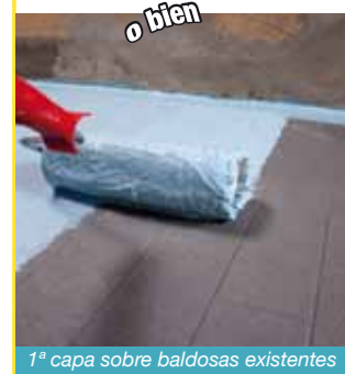
1ª capa sobre baldosas existentes
