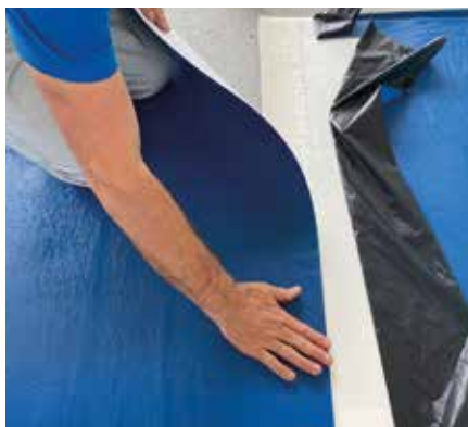
Solapamiento longitudinal de los rollos.
