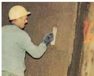
Revoque cementoso con Planicrete . Obra del Túnel de la autopista Ville Marie Montreal - Canadá
