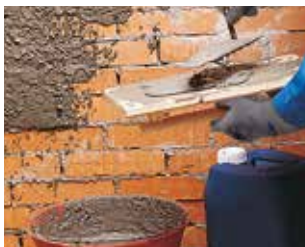
Enfoscado aditivado con Planicrete
