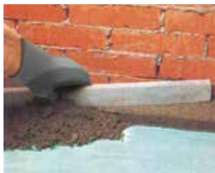
Aplicación de un recrecido cementoso adherente aditivado con Planicrete
