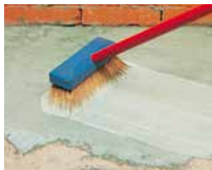
Aplicación de un lechada cementosa aditivada con Planicrete
